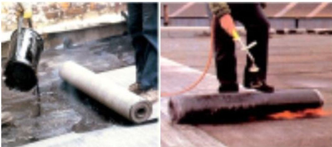
Figure III-6 Systèmes bitumineux soudés à chaud.
