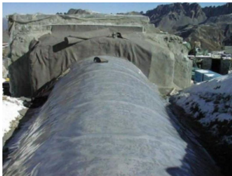
Figure III-1 Application d'un géomembrane synthétique "protection extradoss".
