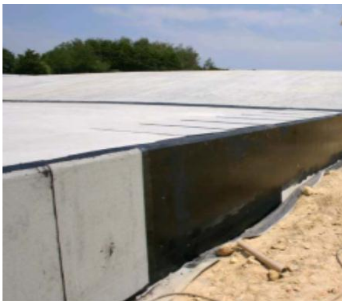
Figure III-5 Système d'étanchéité à base d'asphalte coulé.
