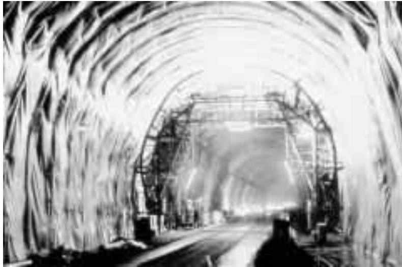
Figure 0-3 Etanchement par feuille.
