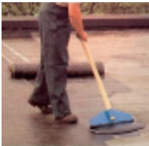
Figure III-7 Systèmes bitumineux adhésifs à froid.
