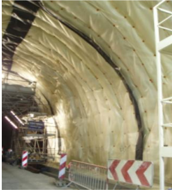
Figure III-3 Géocomposite de protection et drainage.
