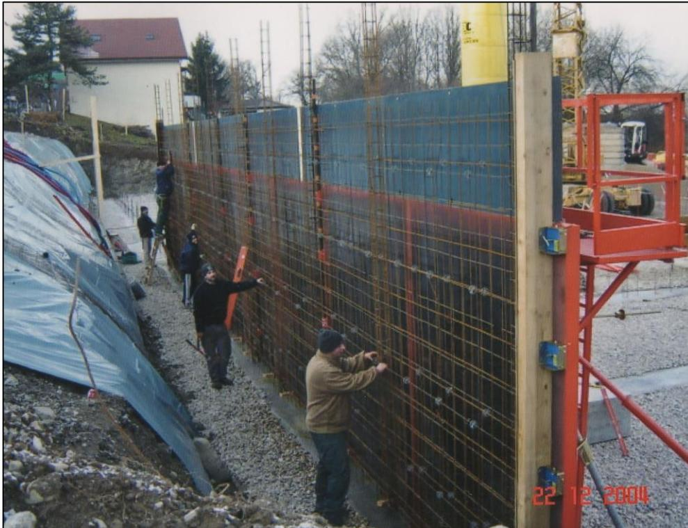
Figure 0.6 : Coffrage voiles en banches avec disposition des armatures.
