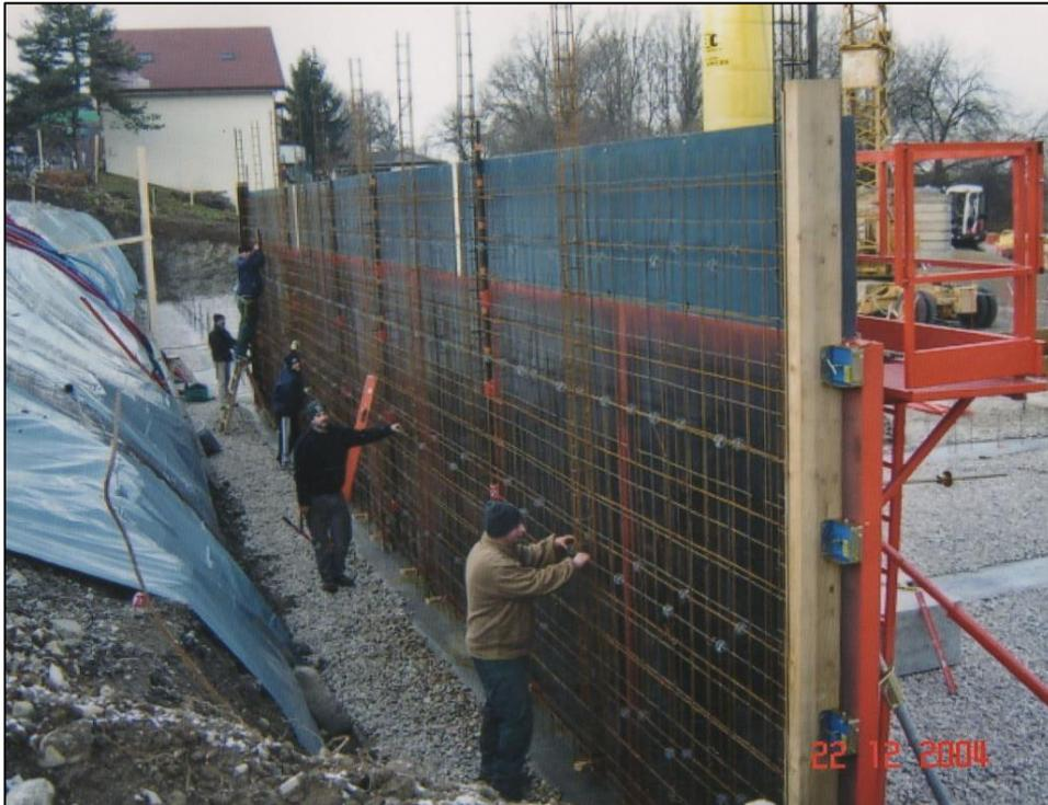
Figure 0.8 : Ferrailage voiles.
