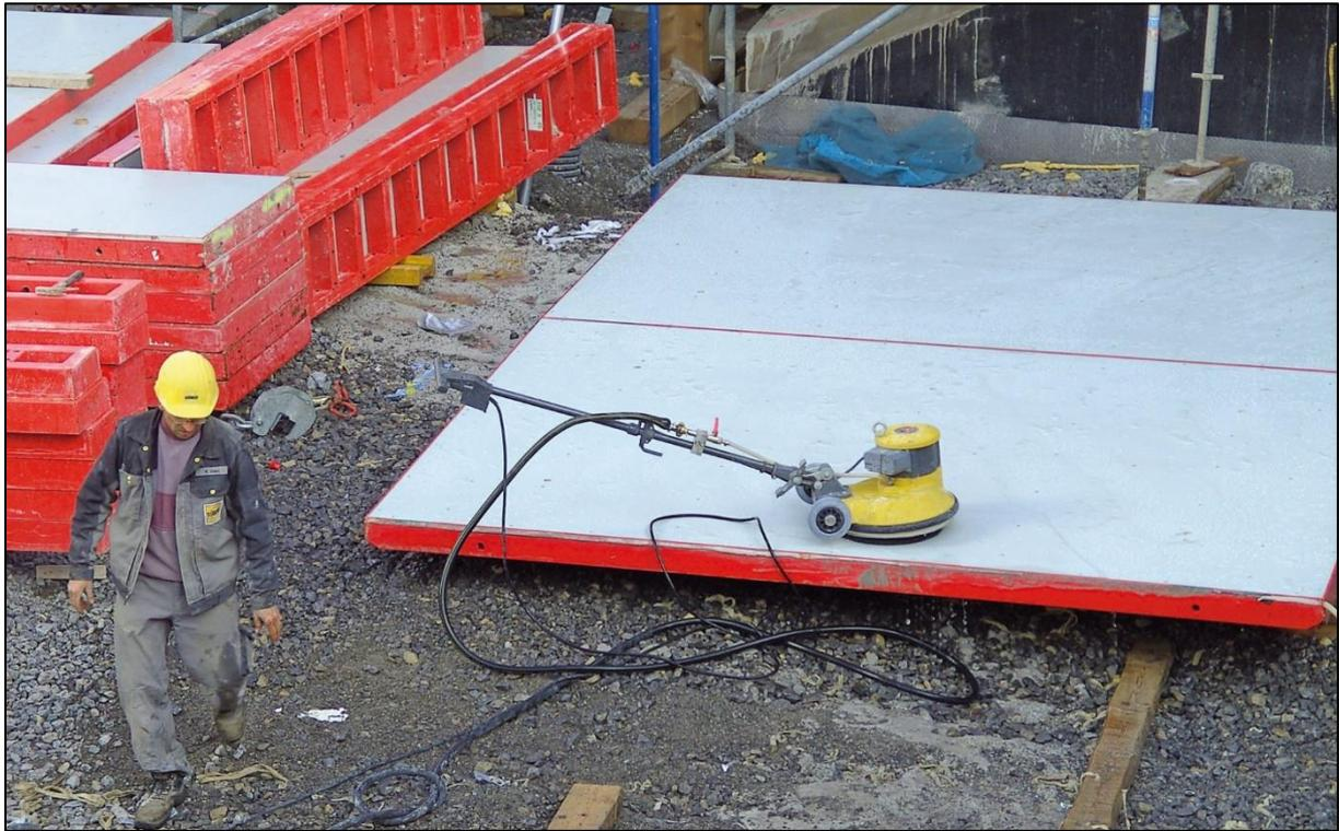
Figure 0.4 : Nettoyage coffrage.
