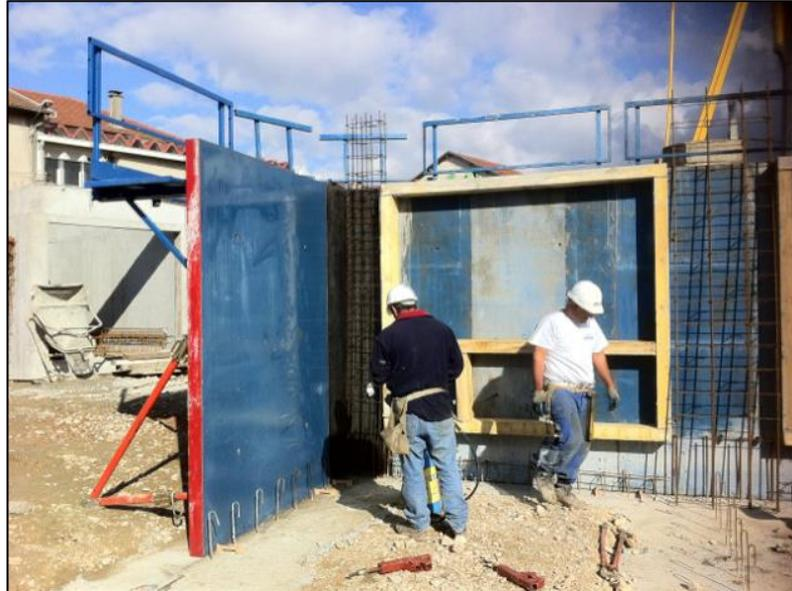
Figure 0.5 : Coffrage voiles en banches avec ouvertures.
