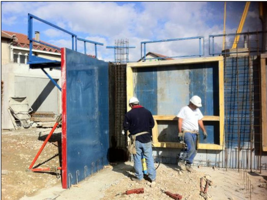
Figure 0.5 : Banches avec ouvertures.
