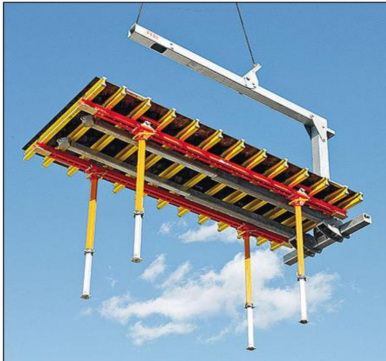
Figure 0.9 : Manutention d'une table de coffrage.
