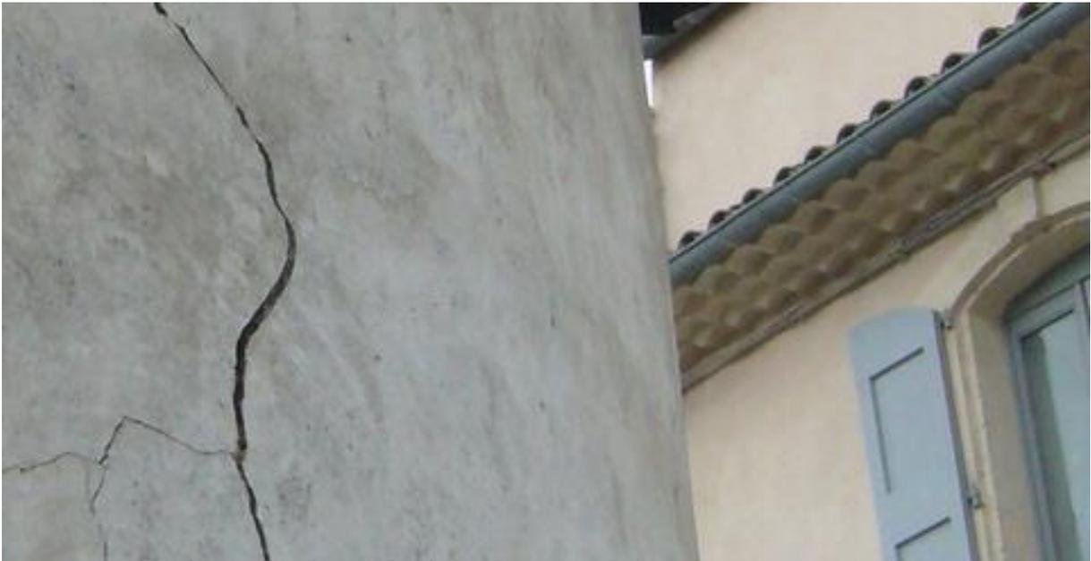
**Figure 2.1:**Exemple d'un béton fissuré (source : [www.lamy-expertise.fr](http://www.lamy-expertise.fr))
