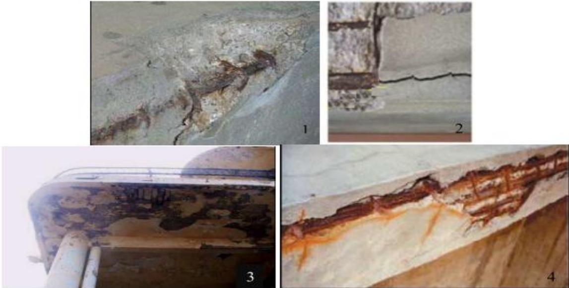
**Figure 3.5:** Exemples de corrosion par carbonatation et d'éclatement de béton d'enrobage
