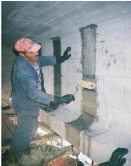
Figure III.1: Application d'une couche de résine.
