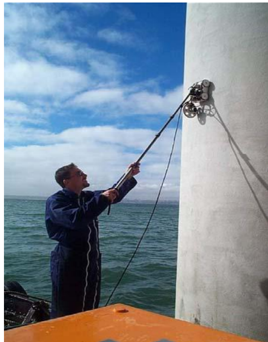
Figure II.01: Détection des armatures au radar.
