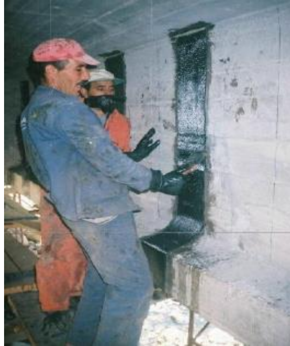
Figure III.2: Application d'une couche d'imprégnation de la même résine.
