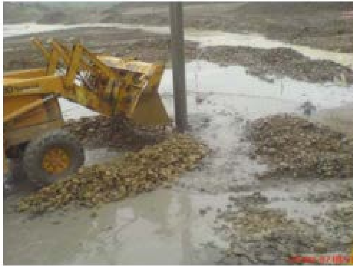
Figure 3 - 6 : Remplissage du trou par le ballast.
