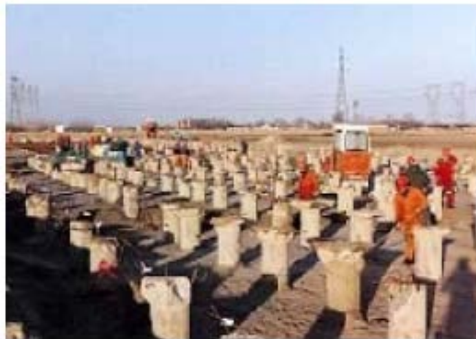
Figure 2 - 8 : Réseau d'inclusions rigides.
