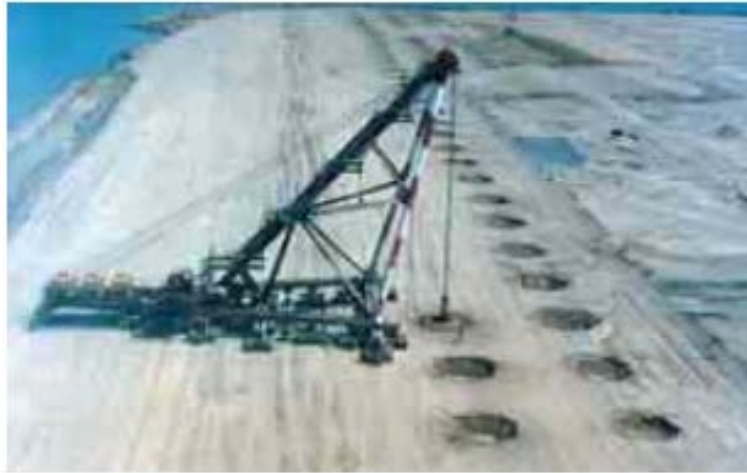
Figure 2 - 7 : Chantier de compactage dynamique (aéroport de Nice-France).
