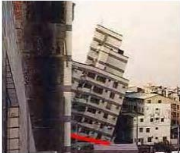
Figure 1 - 15 : Bâtiments renversés à TAIWAN en 1999.
