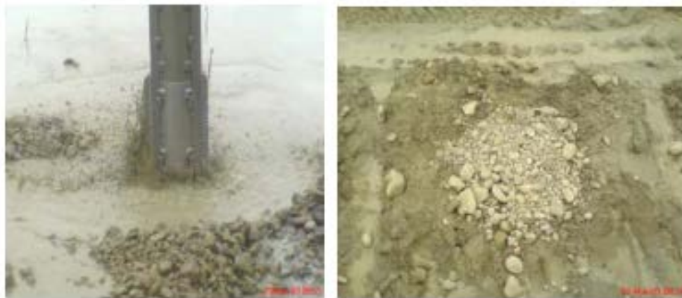
Figure 3 - 7 : Finition d'une colonne ballastée réalisée par voie humide.
