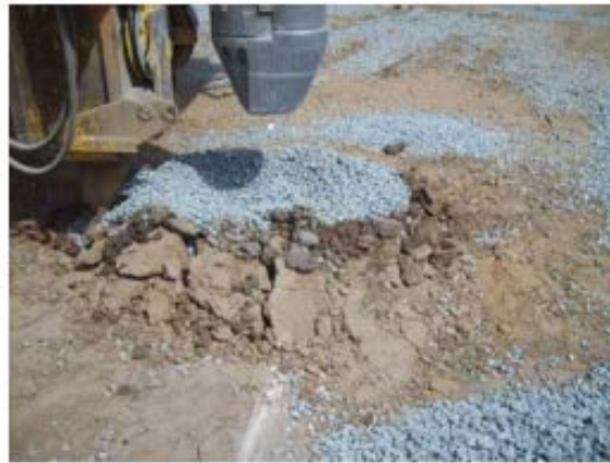
Figure 3 - 2 : Finition d'une colonne ballastée réalisée par voie sèche.
