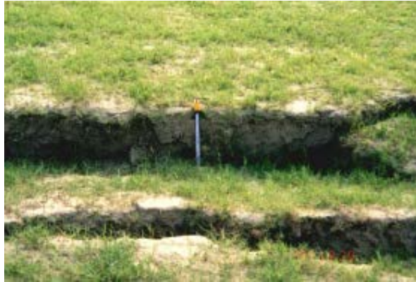
Figure 1 - 14 : Fissures considérables dans le sol à Nantou.
