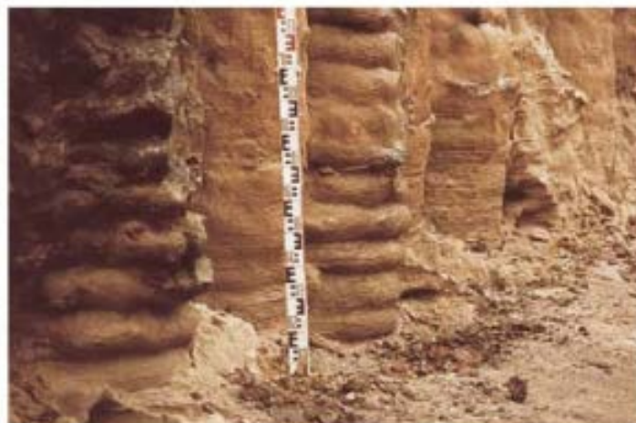
Figure 2 - 19 : Colonnes de Soilcrete.
