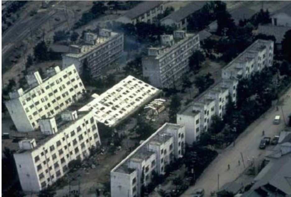
Figure 1 - 3 : Inclinaison des bâtiments d'appartements de Kawagishi-cho à Niigata au Japon dues à la chute de la capacité portante du sol par liquéfaction (d'après Peter M. Byrne et al, 2008).
