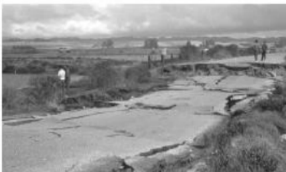
Figure 1 - 9 : Epanchage latéral le long de la route Sandholdt (à gauche) et destruction d'un centre de recherche (à droite) à Moss Landing. (D'après le Earthquake Engineering Research Center, University of California, Berkeley; Elgamal et al, 2001).
