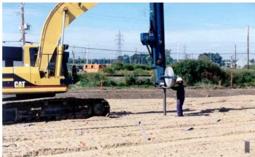
Figure 2 - 2 : Installation des drains verticaux.
