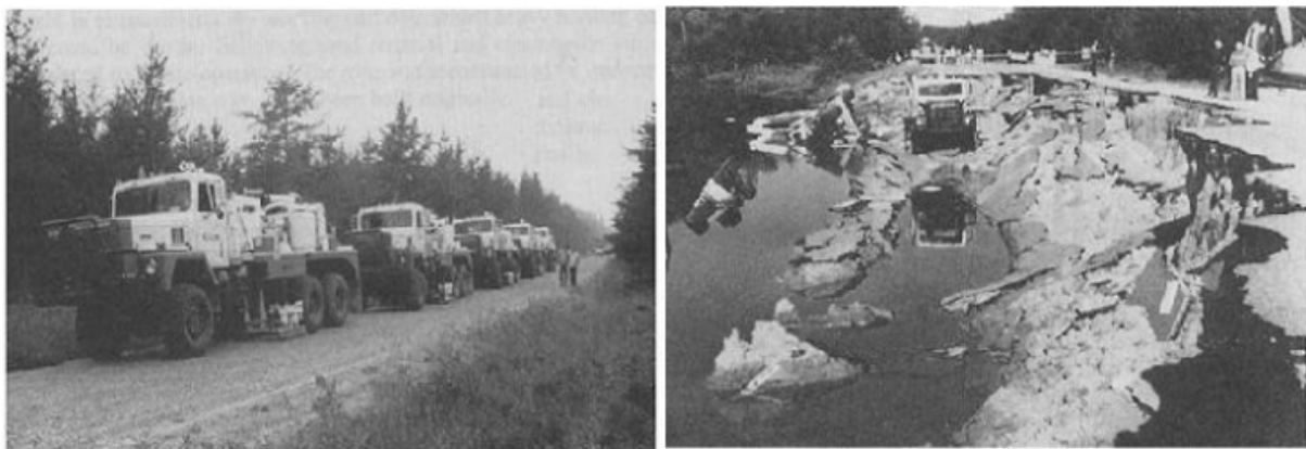
Figure 1 - 7 : Rupture de remblai sur le lac Ackermann déclenché par un train de camions vibrosismiques (d'après Mike Jefferies et Ken Been, 2006).
