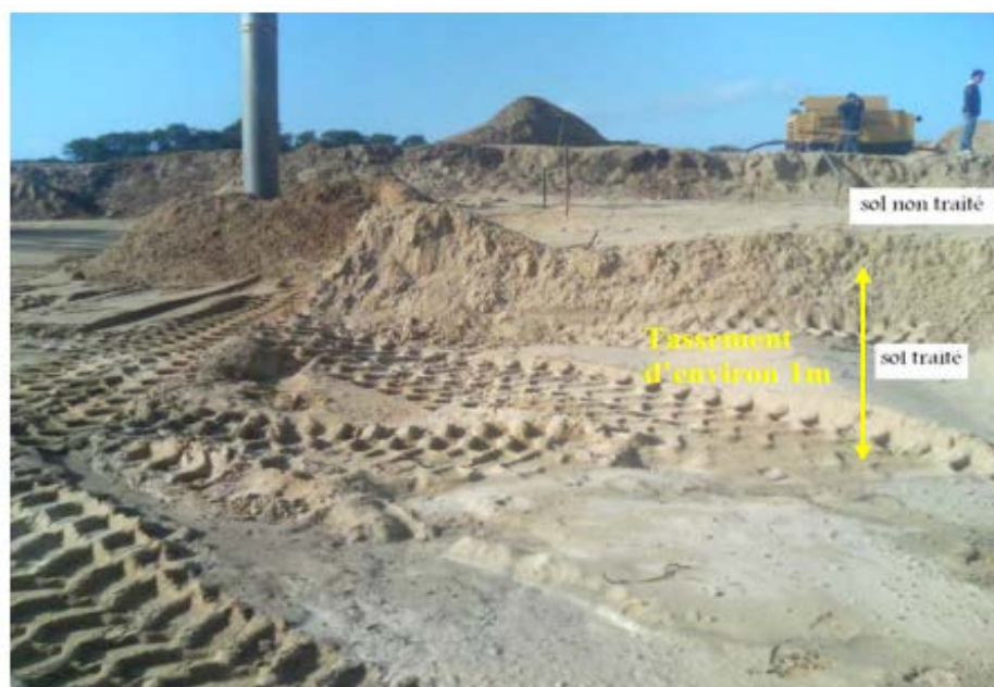
Figure 2 - 15 : Etat de compacité du sol avant et après traitement.
