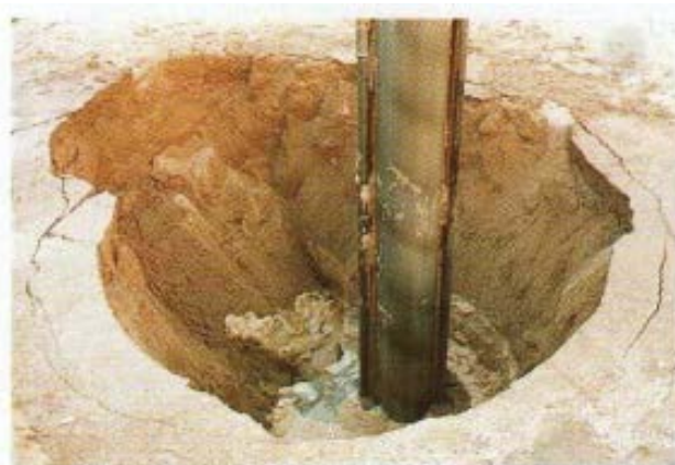
Figure 2 - 12 : Le cône d'affaissement autour du vibreur.
