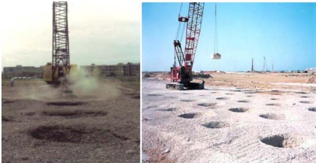
Figure 2 - 4 : Exemples de chantiers de compactage dynamique.
