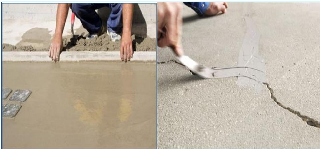
Figure. 2.1. Le ragréage d'une structure en béton.
