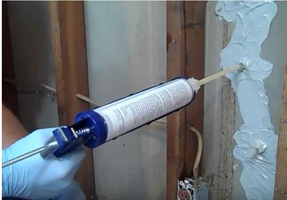
Figure 2.2. Injection des fissures
