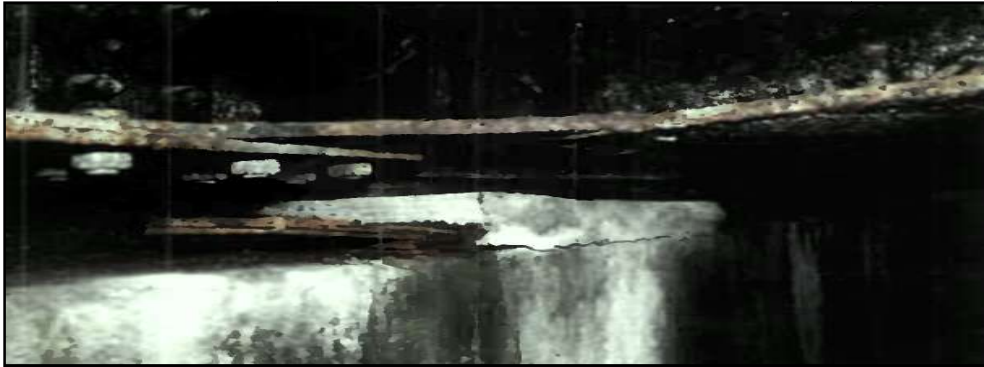
Figure I.14 : oxydation des tôles de calage.
