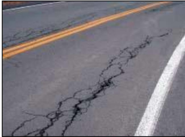
Figure 1.10. Fissure longitudinale [54]
