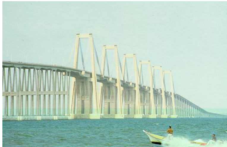
FIGURE 1.6 – Pont de Maracaibo : Pont haubané à mât très rigide
