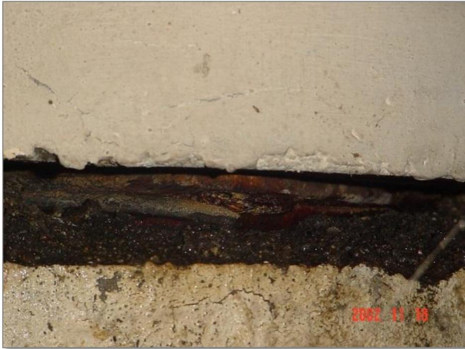
Fig 5.12 : Pont 3, axe 6, appareil d'appui D. Corrosion très importante des frettées.
