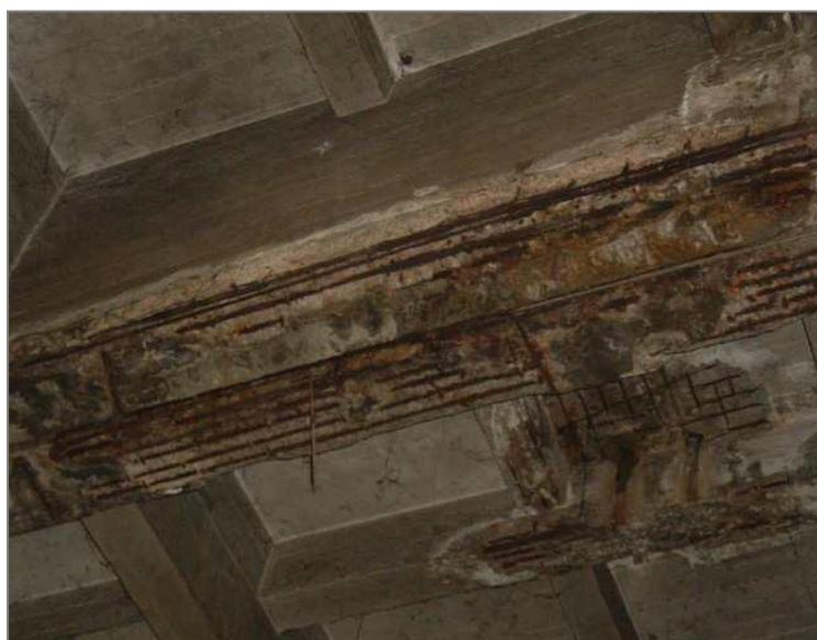
Fig II.2 : Eclatement de béton et la corrosion des armatures
