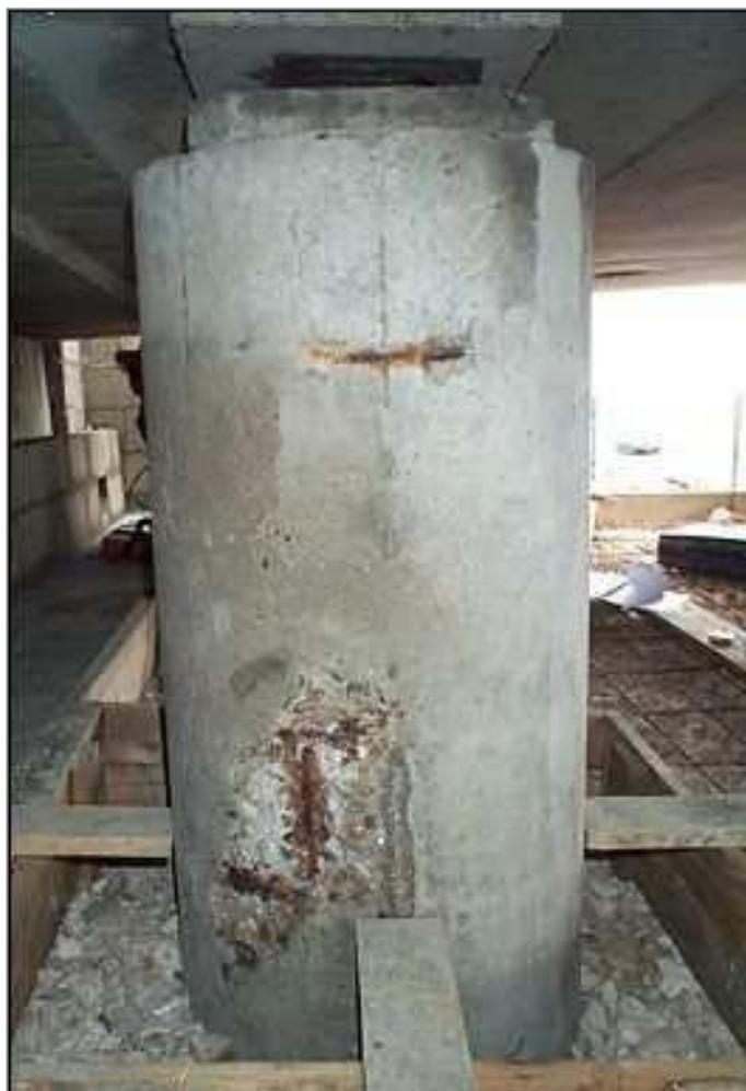
Fig II. 9 : gonflement de béton et corrosion des armatures
