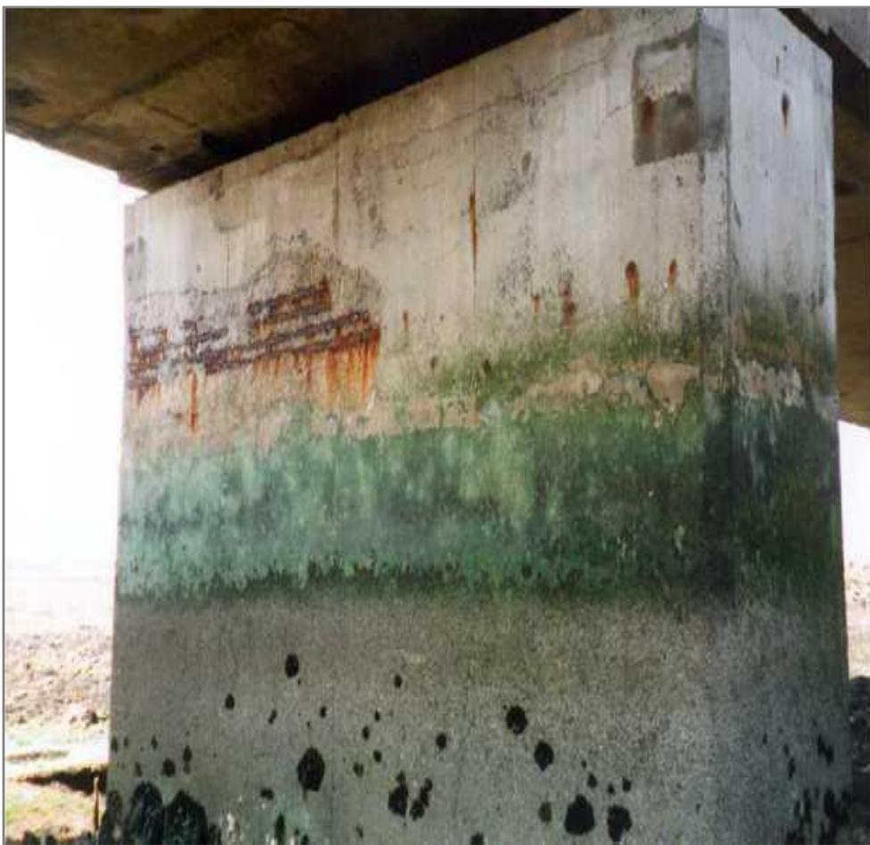
Fig I.7 : Pile en zone de marnage
