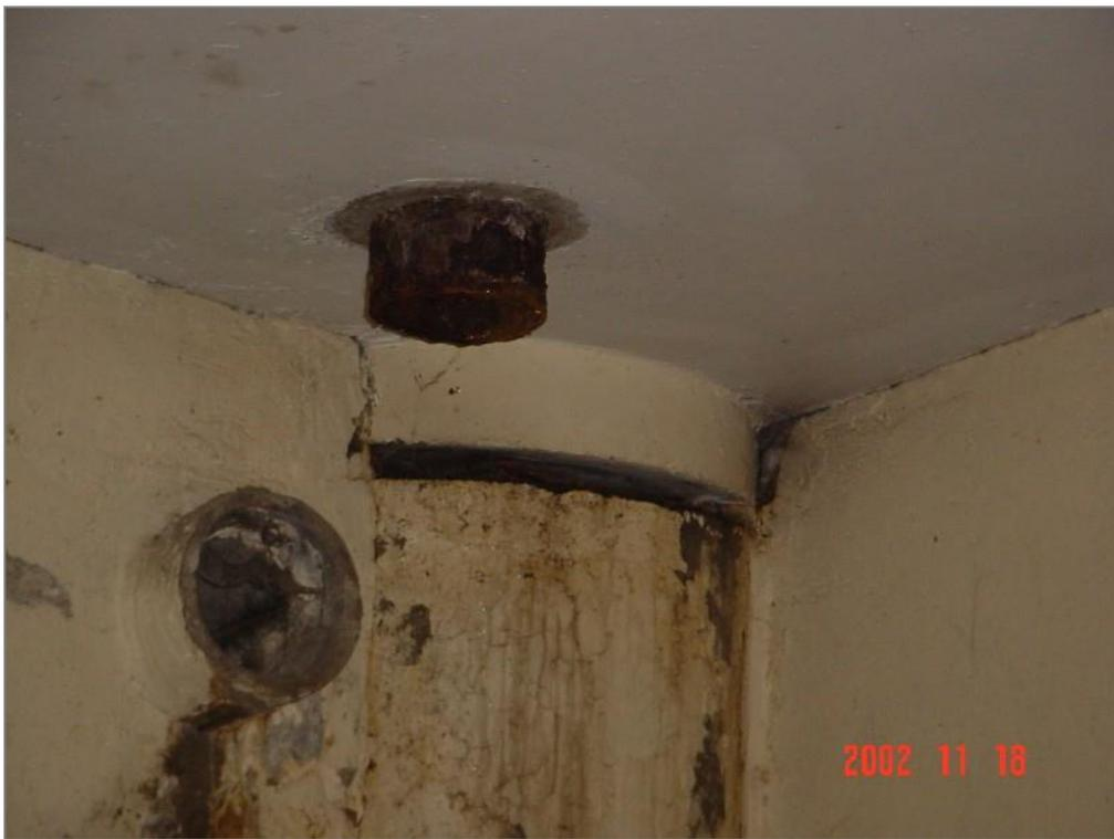
Fig 5.11 : Infiltration d'eau par du béton et corrosion légère de l'armature.
