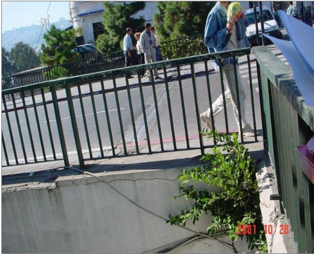
**Fig 5.8 :** Mur en retour de la culée, Délaminage de dessus du mur Pont 2, axe 6, colonne D.
