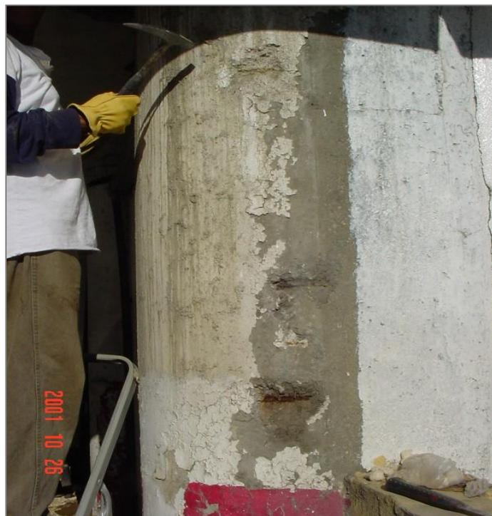
**Fig 5.9 :** Corrosion légère de l'armature.
