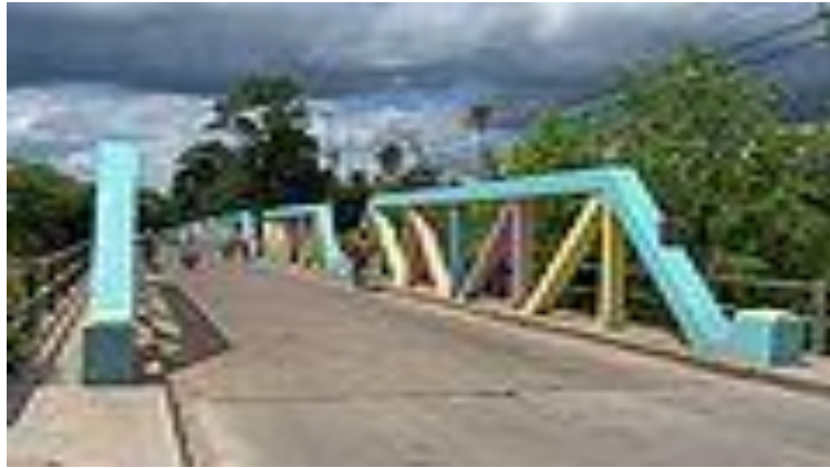
Figure. I.12. Pont en treillis Pony
