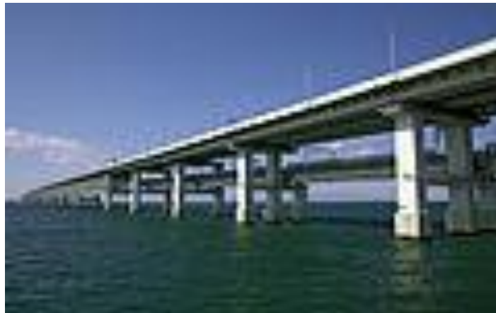
Figure. I.13. Pont à double tablier
