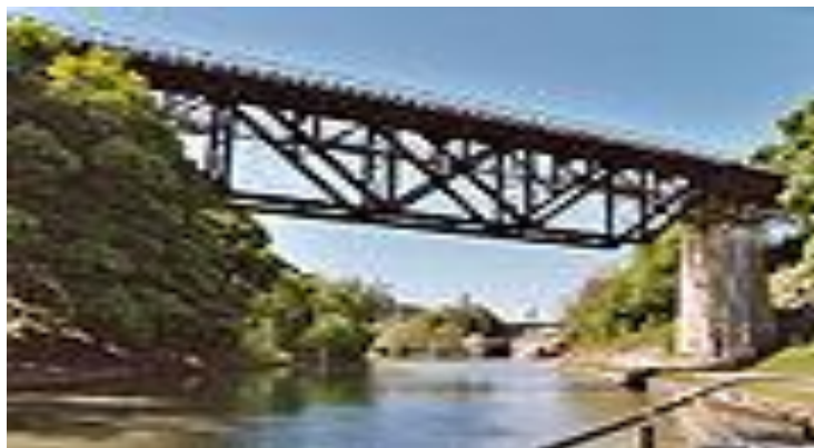
Figure. I.10. Pont à tablier supérieur
