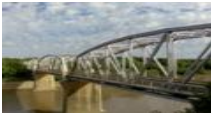
Figure. I.11. Pont à tablier inférieur
