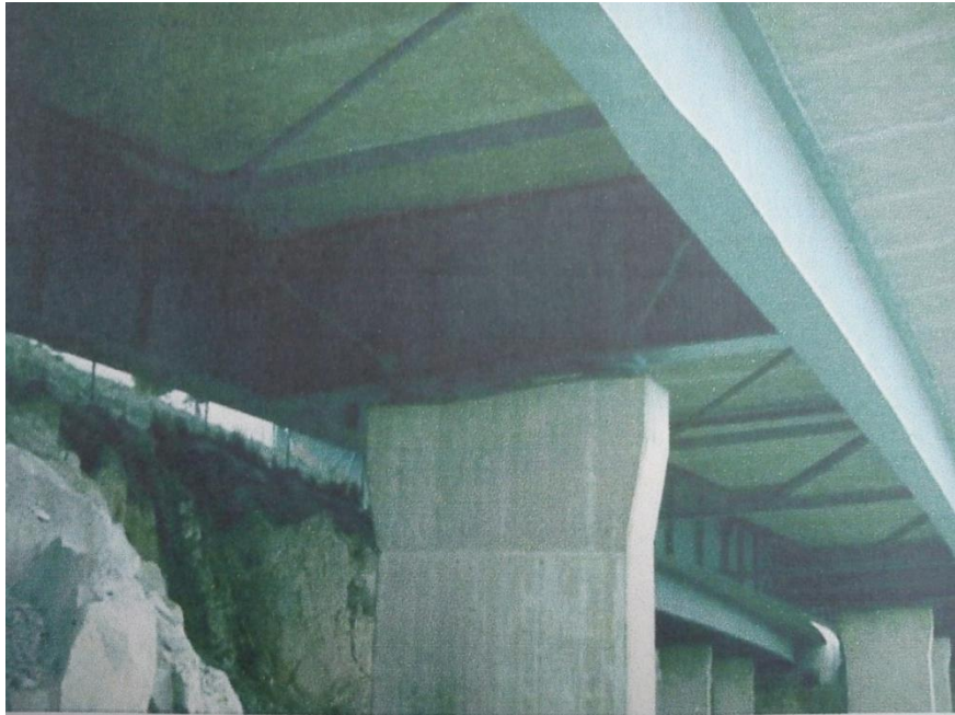
Figure. I.5. Exemple d'un bipoutre mixte
