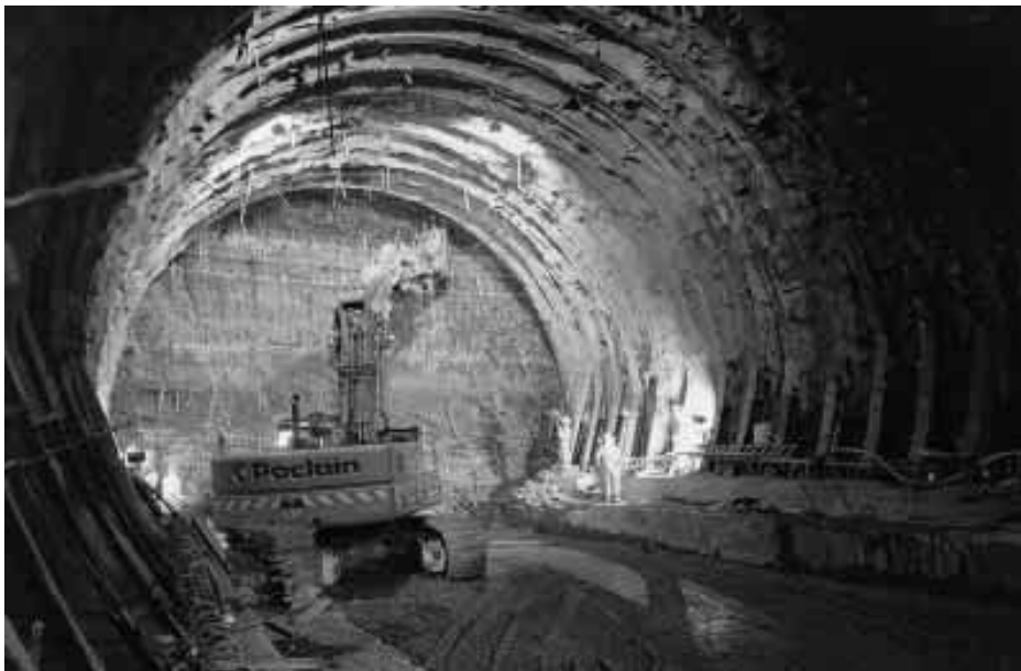
Figure III. 1 : Creusement en section pleine.
