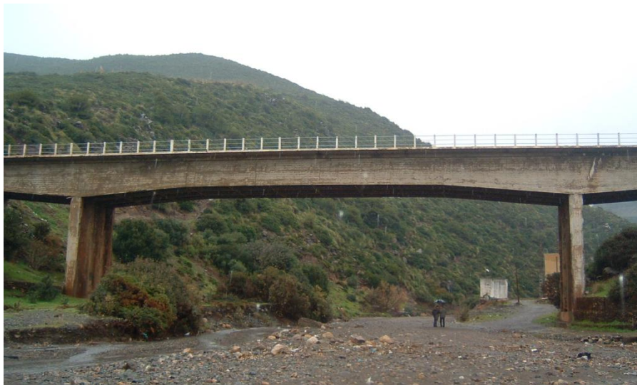
Figure II.1. Vue d'ensemble du pont OUMAZER
