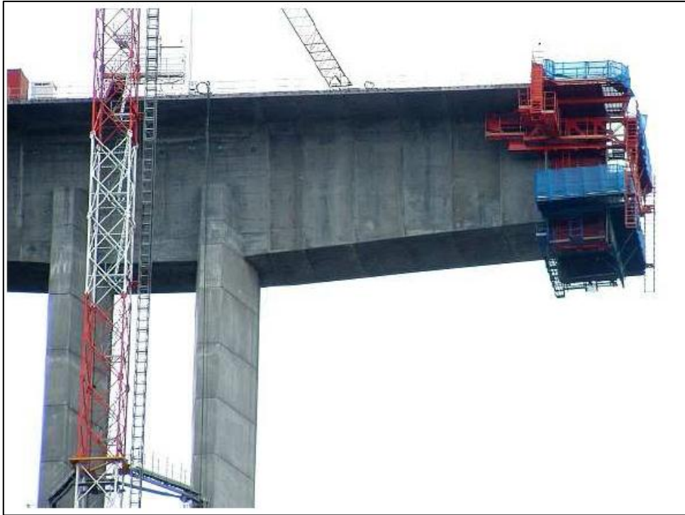
Figure 3 Voussoir coulé sur place
