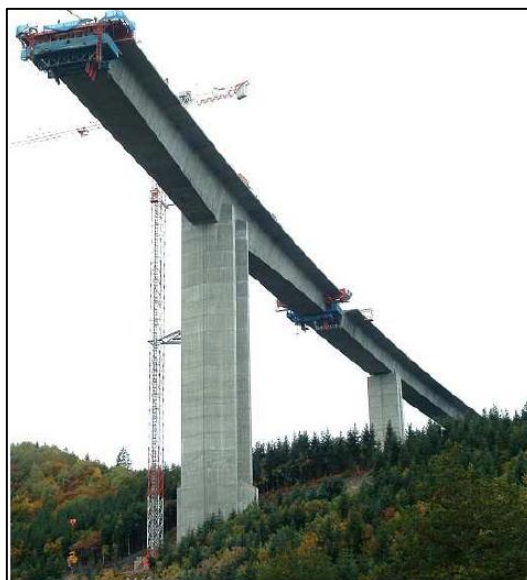
Figure 1 Construction d'un fléau
