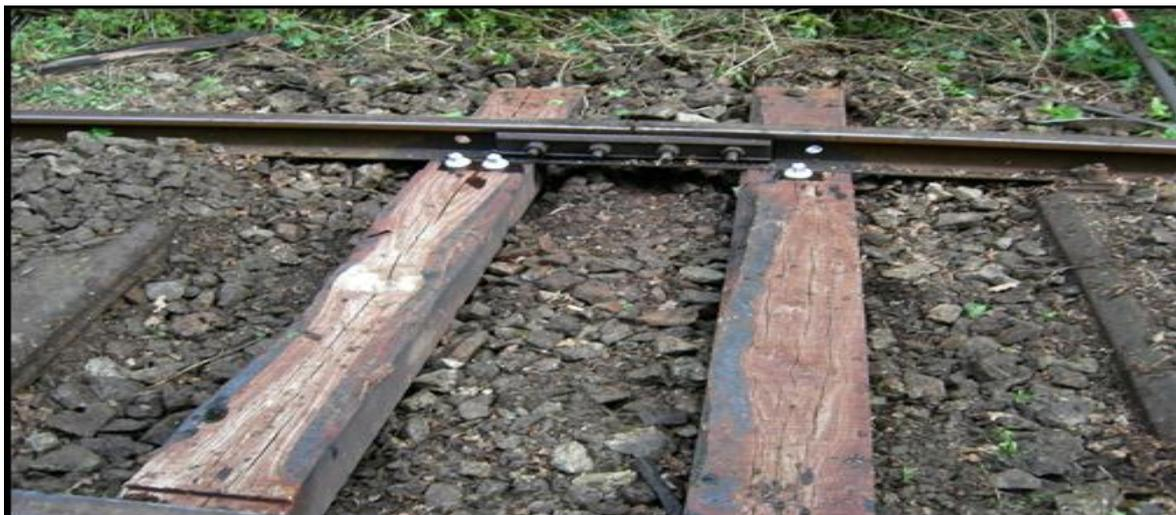
**FIGURE N° 47** Traverse à remplacer en bois
