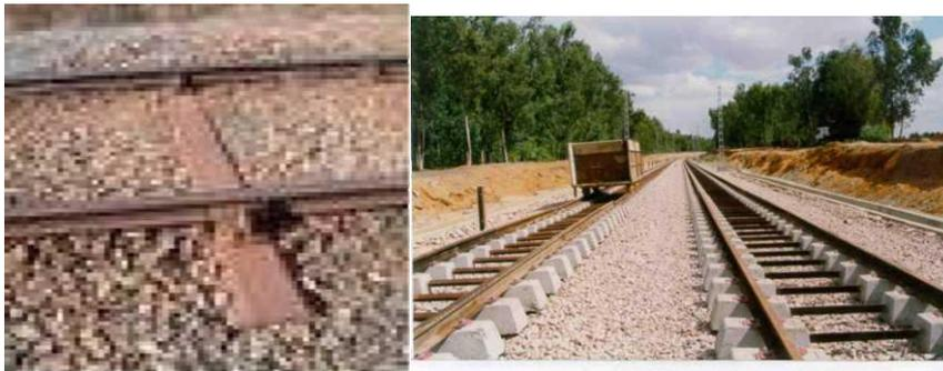
**Figure N°II-14 : Traverse en Bois Figure N° II-15 : Traverse en béton**
