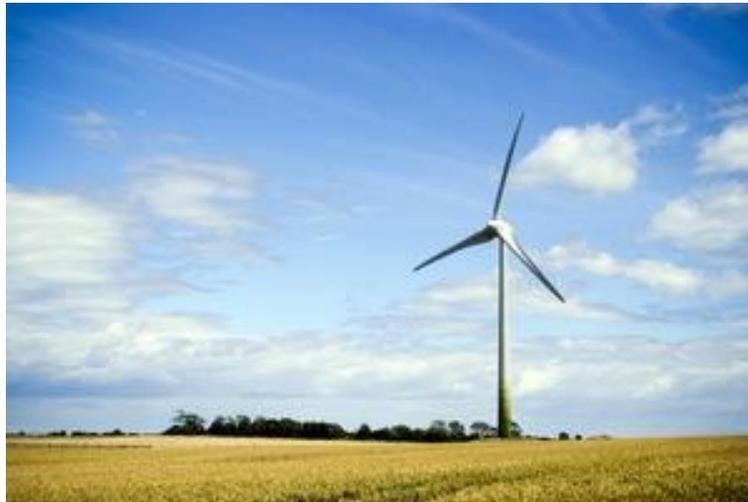
Figure 1-4 Eoliennes à axe horizontal. [9]
