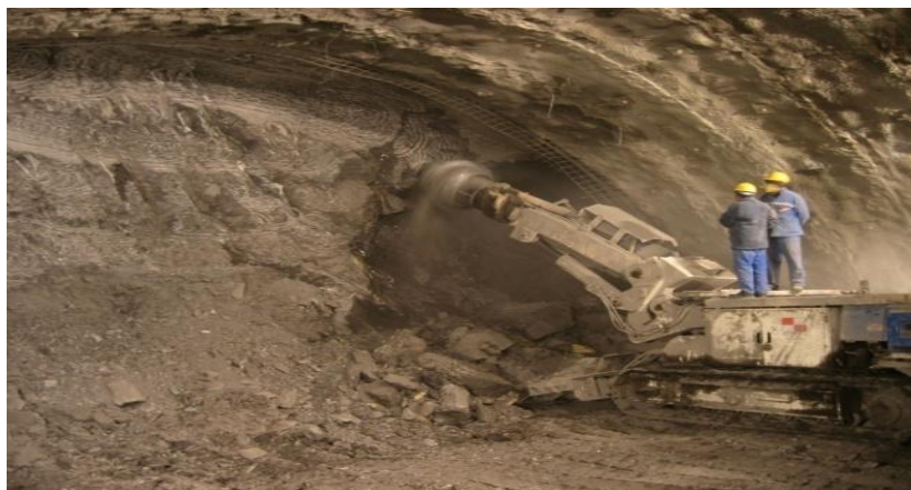
Figure III.6 : machine à attaque ponctuelle
