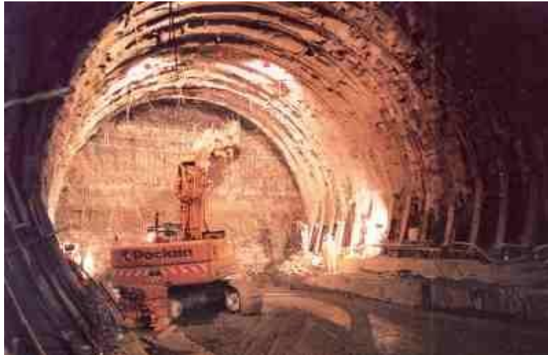
Figure III.1 : creusement à section globale
