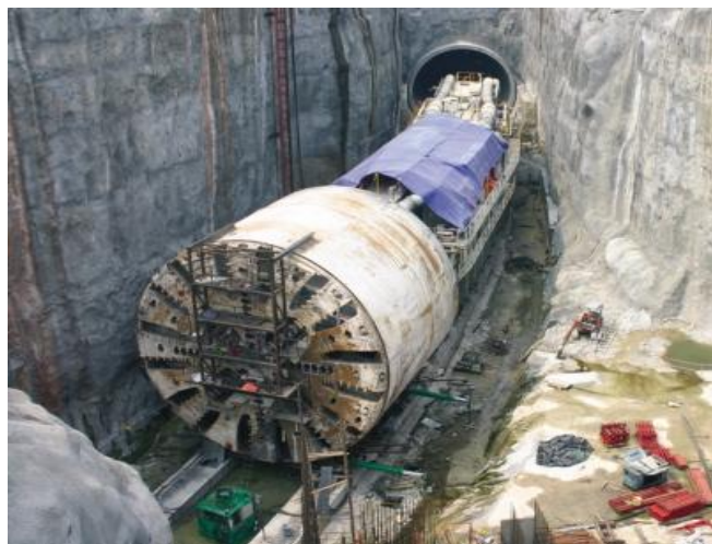
Figure III.5: machine à attaque globale
