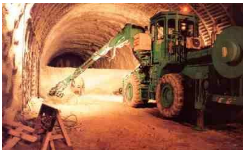
Figure III.2 : creusement en demi-section
