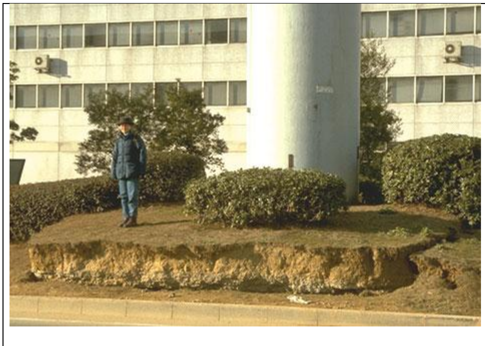
Figure I.11 : Tassement généralisé à Kobe, Japon, 1995 [9]
