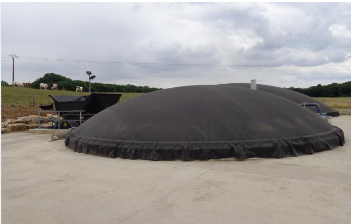
Figure 18: Digesteur de la ferme expérimentale de l'ENSAIA -La Bouzule-
