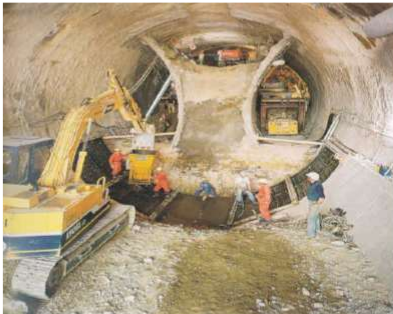
Figure 3.6 : Creusement en section divisée.
