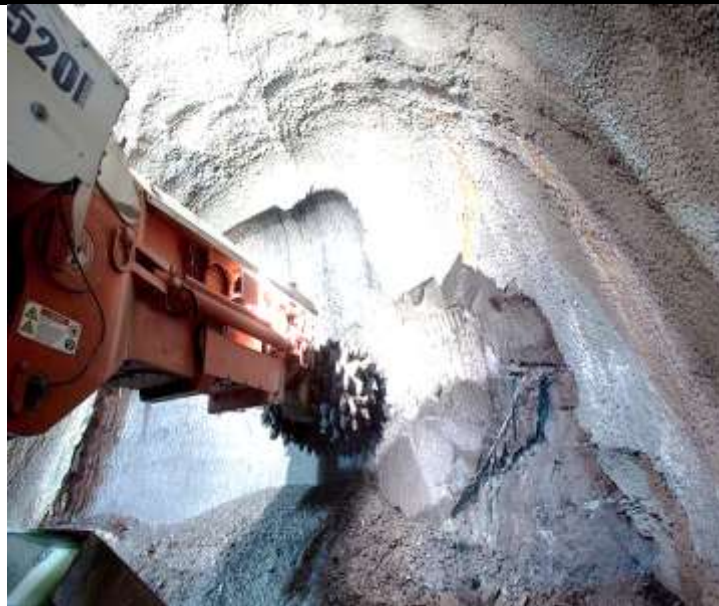
Figure 3.15 : Machine à attaque ponctuelle.
