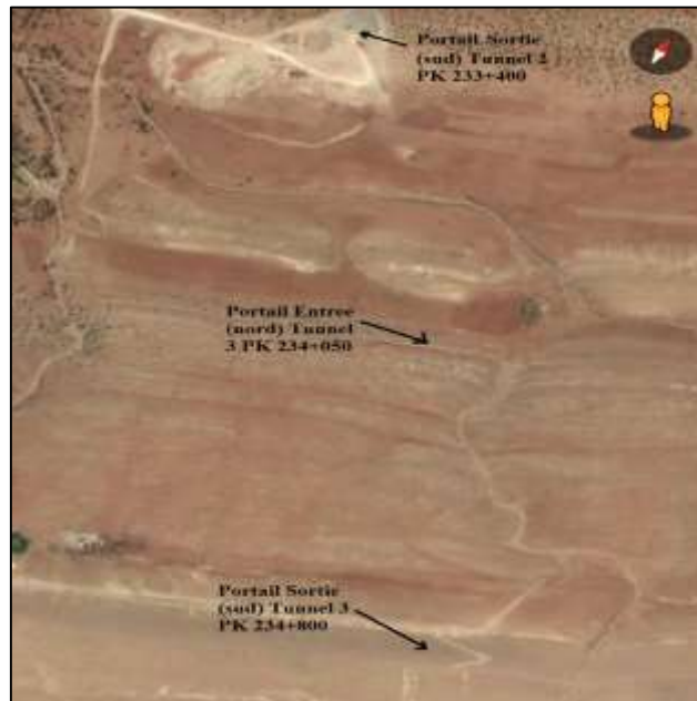
Figure 2.4 : Vue de ciel sur le tracé du tunnel T3 avant la réalisation.
