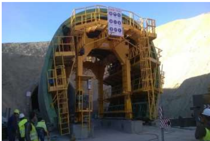
Figure 4.18 : Le support de revêtement. Entrée de tunnel T2/ COSIDER M26.
