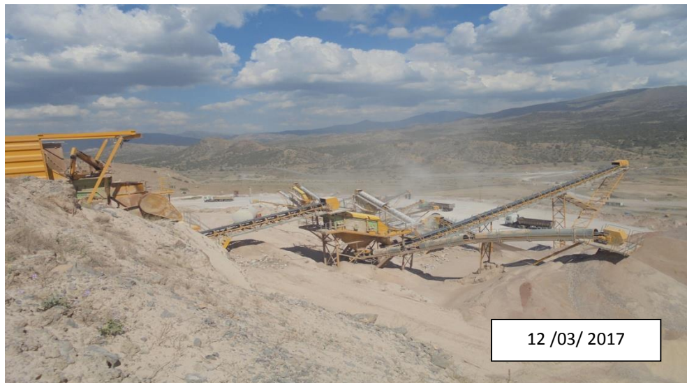
Figure IV.1. Station de concassage d'el M'Hir.
