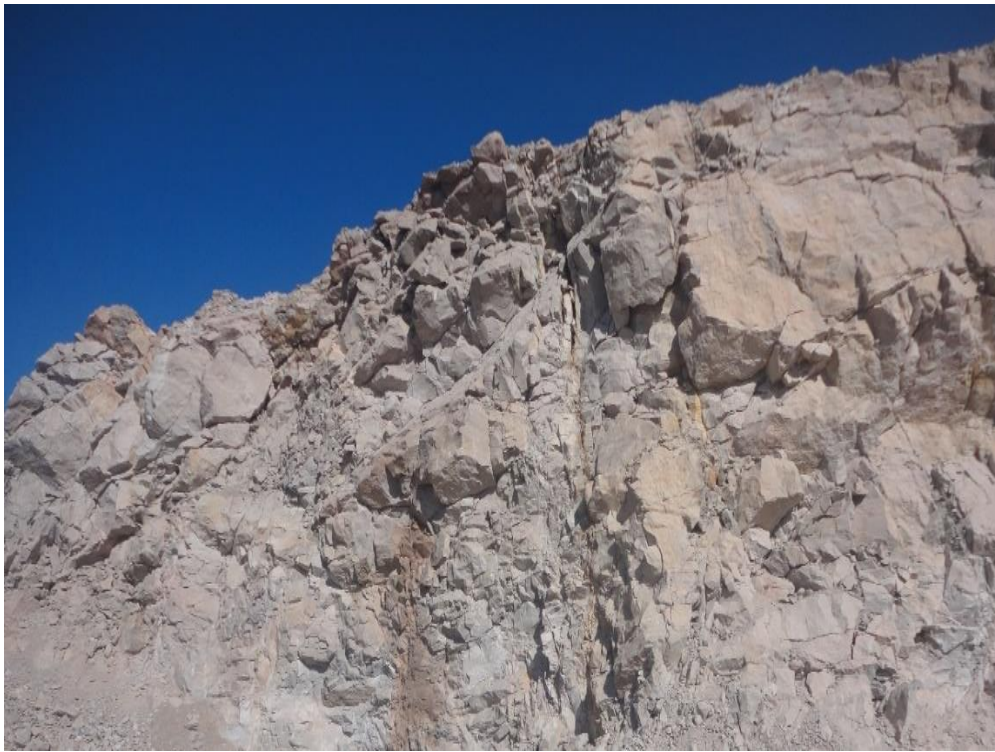
Figure II.1. Talus niveau 770 m.
