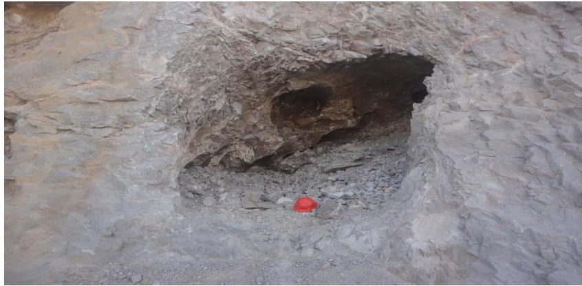
Figure I.8. Cavité karstique niveau 710 m partie ouest.
