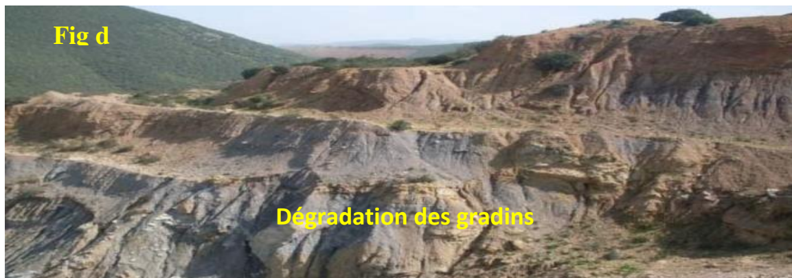
Figure 20: localisation et état des carrières Ismail
