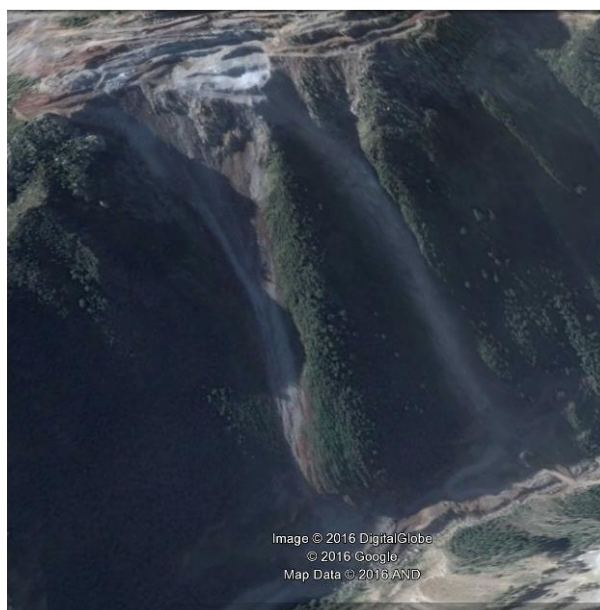
Figure III.4 : les deux couloirs à chute de gisement d'IFRI (vue de satellite).
