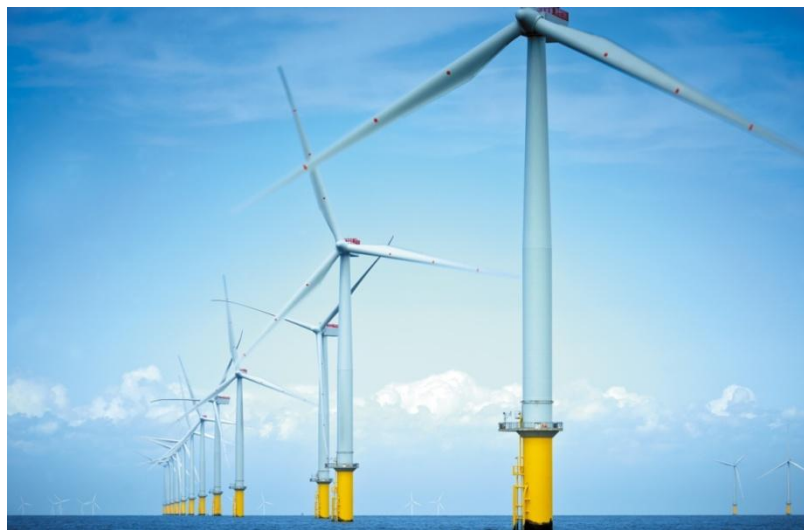
Figure I.7 Partie du champ éolien de London Array [5]
