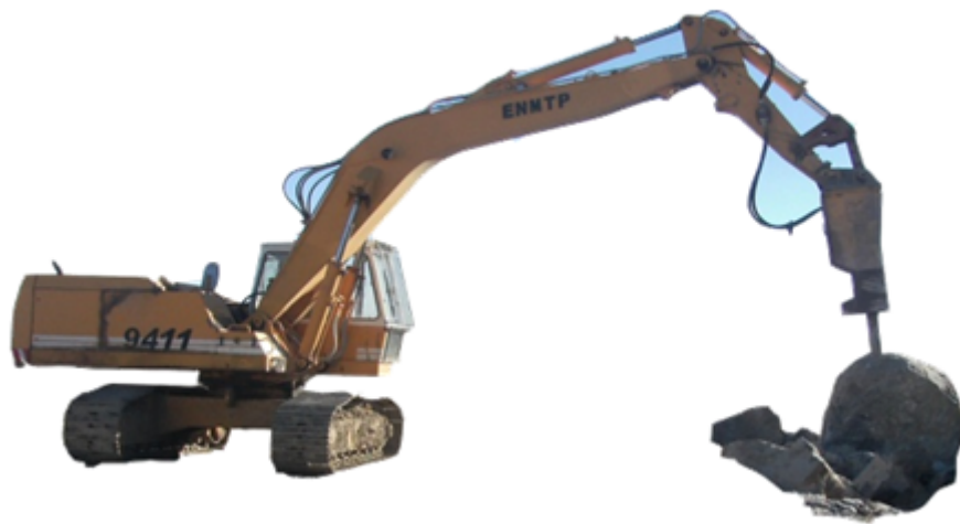
FIGURE III.3 – débitage secondaire des blocs hors gabarit par pelle hydraulique équipée d'un marteau.
