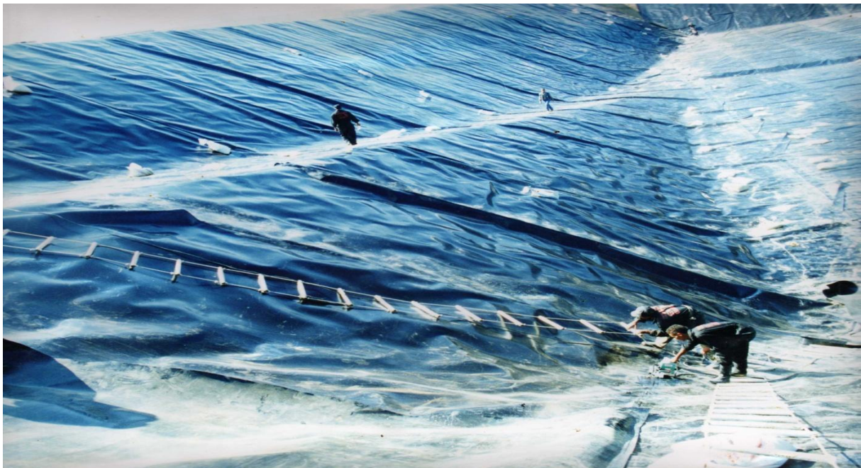
Figure I.2.7 : Mise et soudure de la Géo-membrane.
