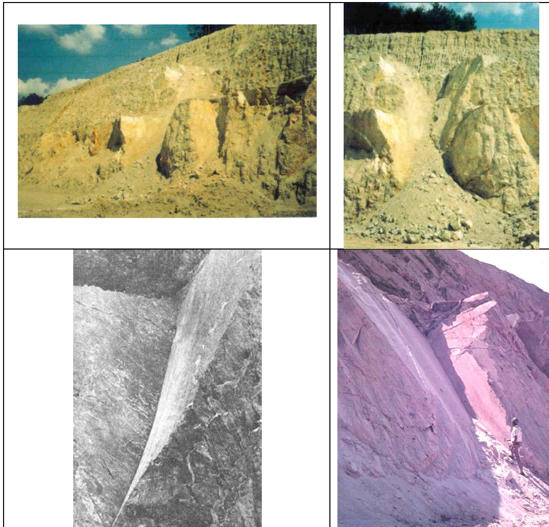
Figure II.11- Exemples de rupture de dièdres.
