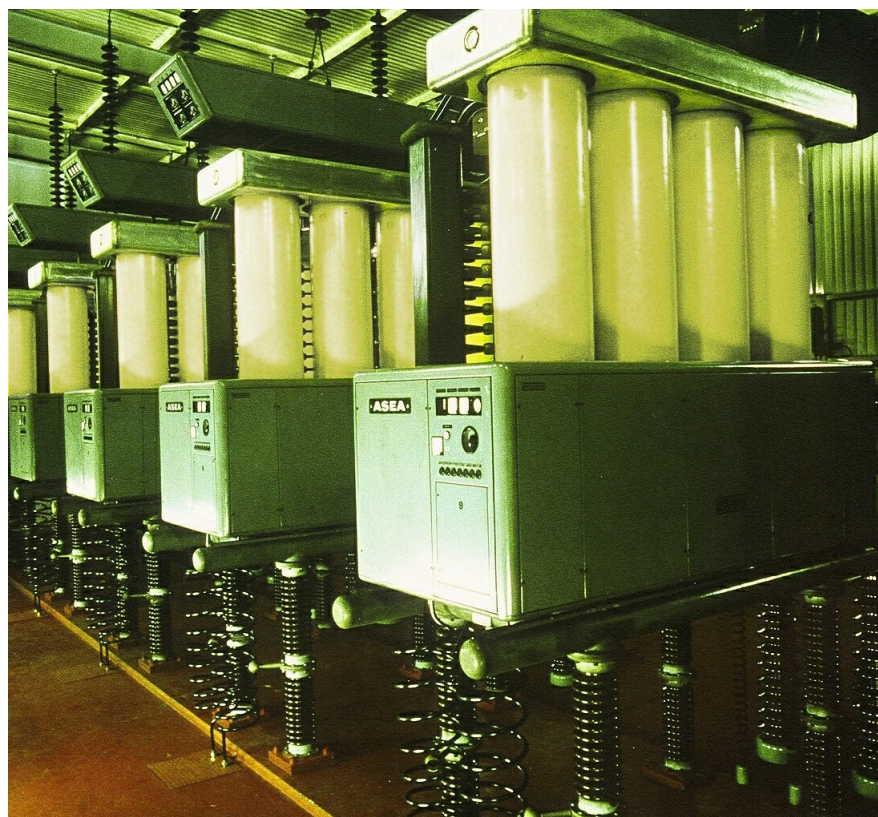
Figure 1.1 – Salle de valves à vapeur de mercure dans la sous-station Haywards de la liaison HVDC "Inter Island - Pôle 1" au Nouvelle-Zélande [25]
