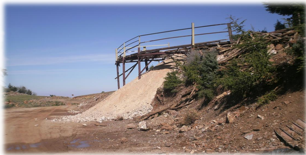
Figure III. 3 : Estacade de déchargement existante au filon n°4
