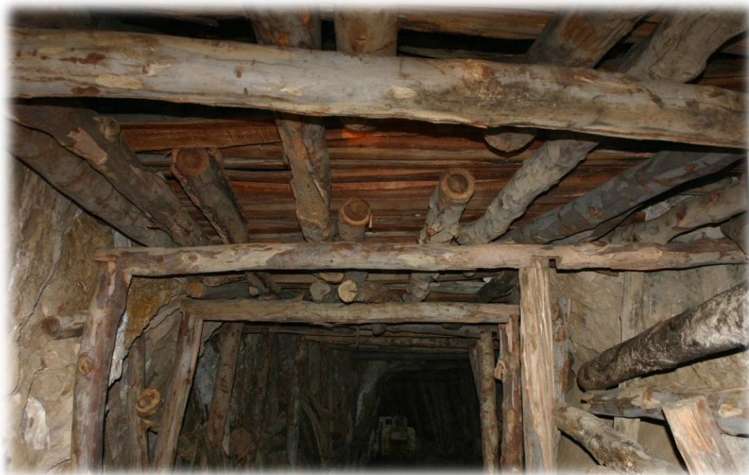
Figure IV. 6 : Soutènement par boisage des galeries à Ain Mimoun.
