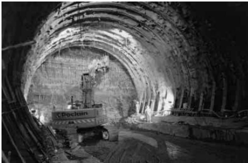
Figure 3.17. — Creusement d'un tunnel en plein section
