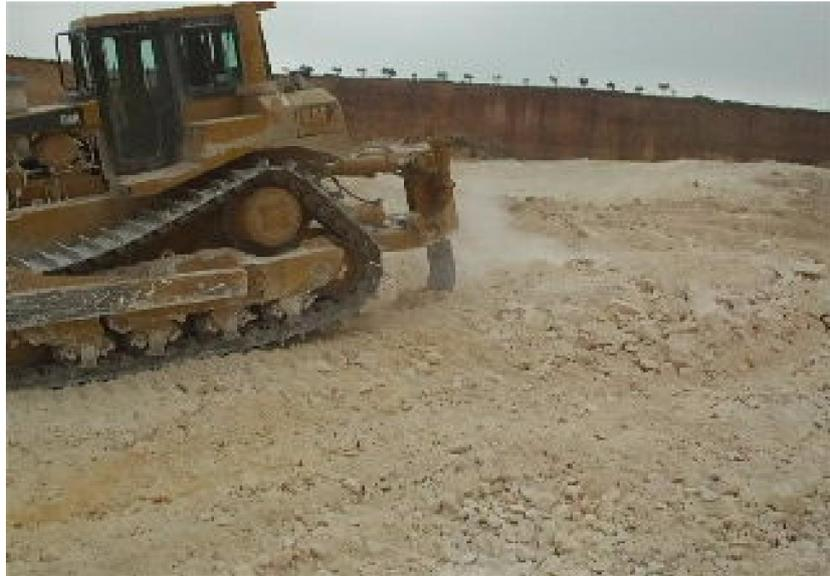
**Figure. III- 12 :** Photo montrant la roche en cours de désagrégation par les rippers du bulldozer.
