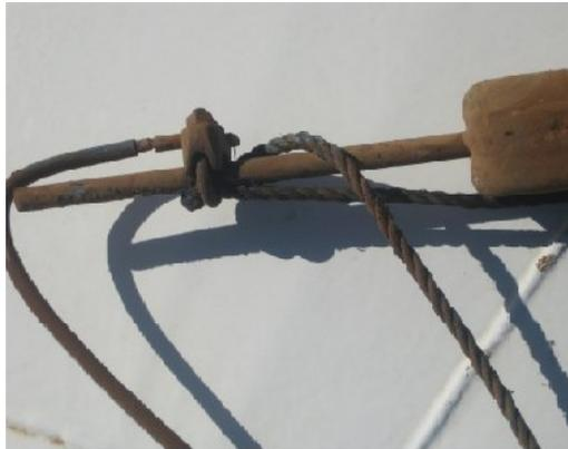
**Figure VI.3.** Représente bonne connexion et continuité du câble pour une anode sacrificielle.
