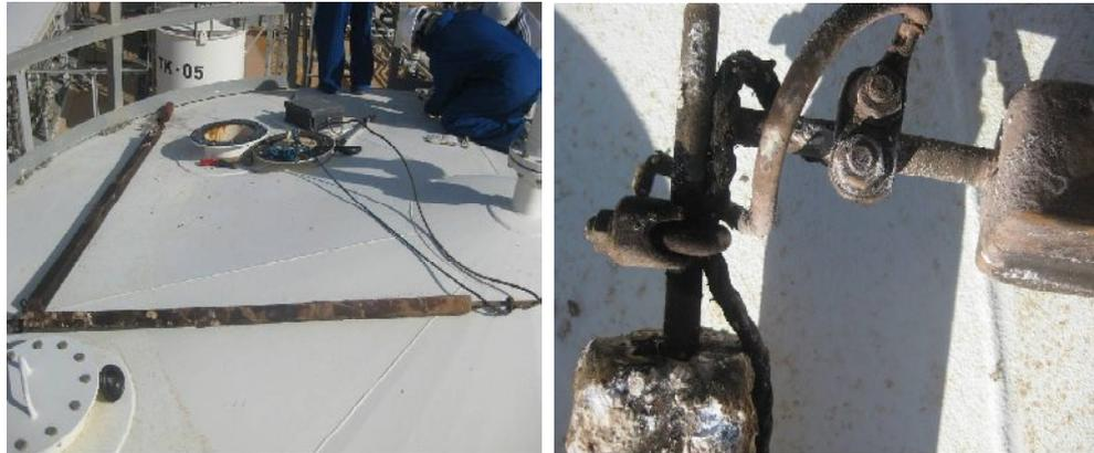
**Figure VI.6.** anode sacrificielle.
