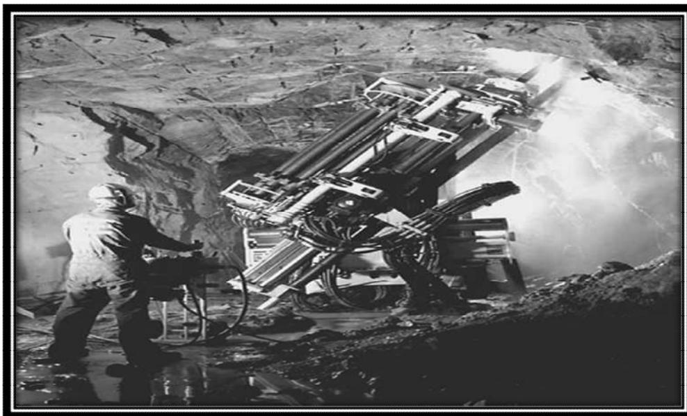
**Figure I.10 :** Machine de foration de longs trous de mine (jumbo)
