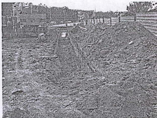
A. Exécution d'une avant-tranchée de faible profondeur.
