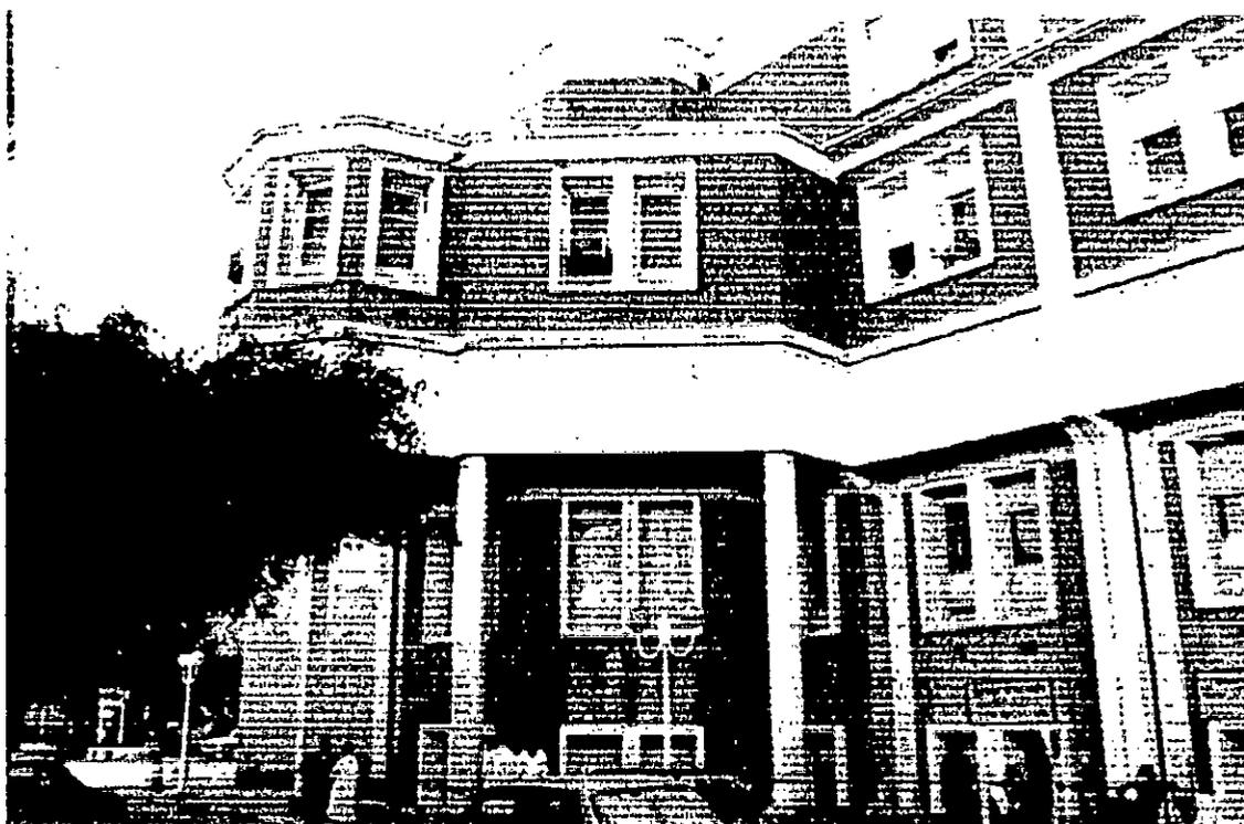
Photo 10 - la surélévation des deux derniers étages de l'aile droite sur une structure en poteaux-poutres, ainsi que le joint entre les blocs « b » et « c »
