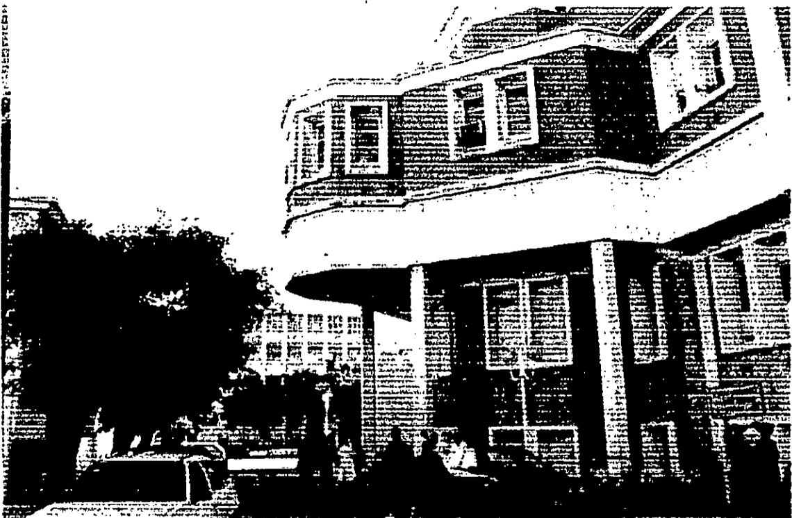
Photo 2 - mise en évidence du porte à faux supporté par des poteaux
