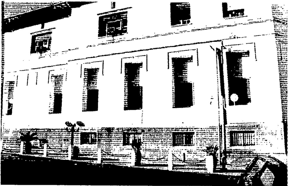
Photo 7 - différence de hauteur d'étage entre le rez-de-chaussée et le 1er étage, ainsi que la différence de la hauteur des ouvertures entre deux niveaux
