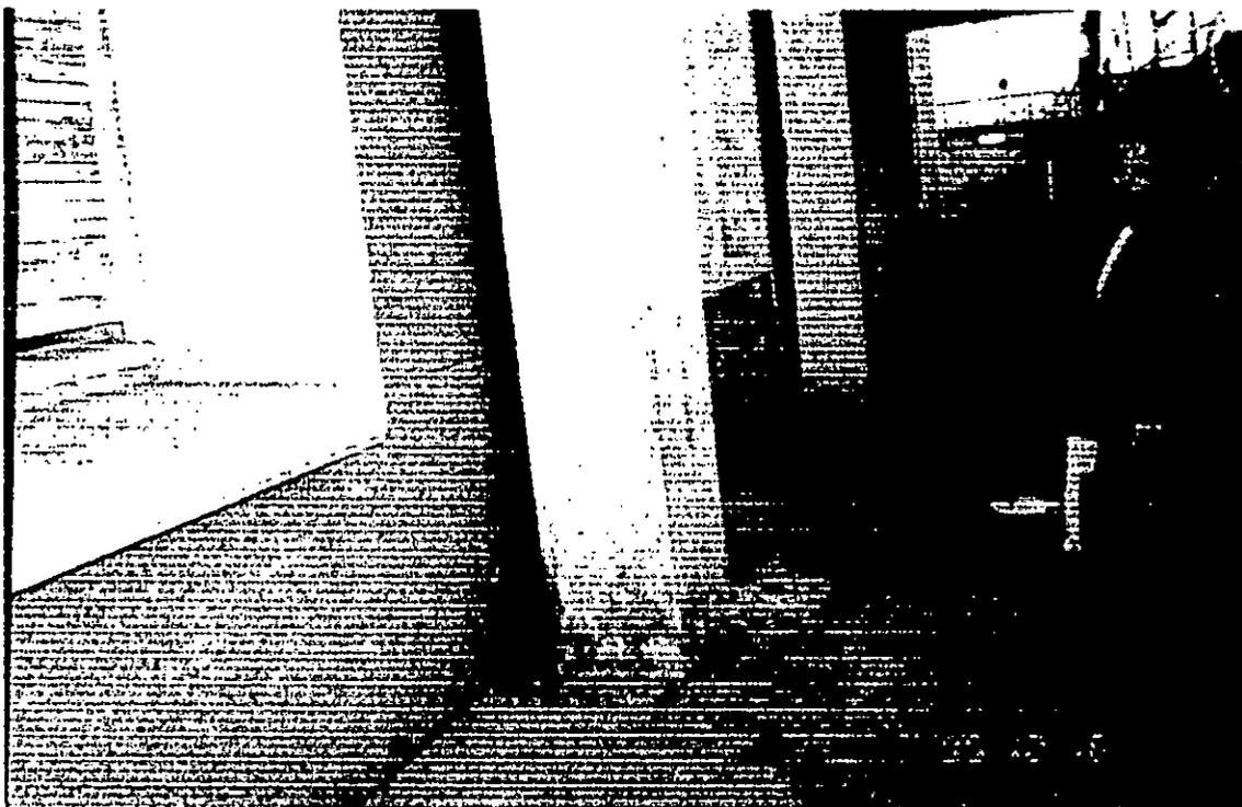
Photo 14 - altération de la base d'un poteau
