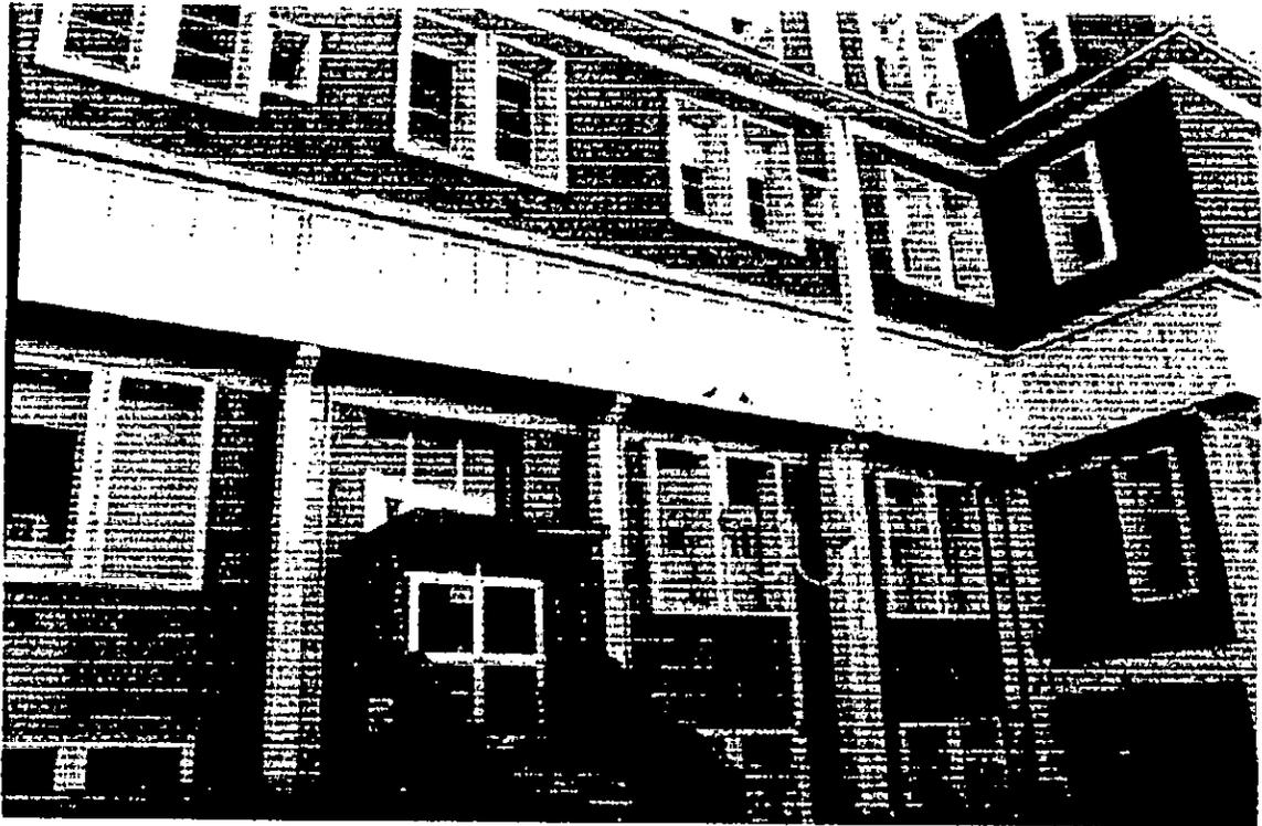
Photo 11 - mise en valeur de la non verticalité du mur extérieur, ainsi le joint séparant le bloc « c » du bloc « d »
