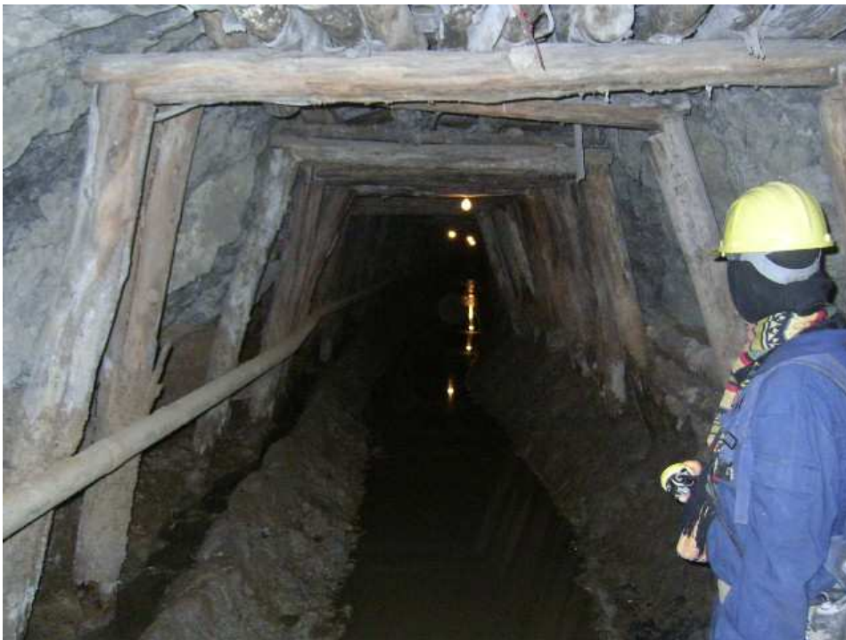
Figure 8. Soutènement par boisage
