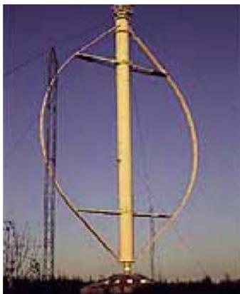
*Figure 1.1 - Turbine à axe vertical.*
