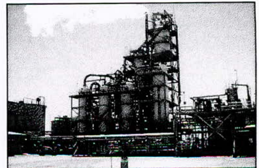
Fig.III.1. Installation d'autoclaves (crédit par : Anglomme, Afrique du Sud).
