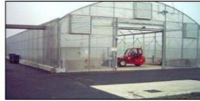
Figure II.3 Exemple de serre fermée - Extraction en pignon [3]
