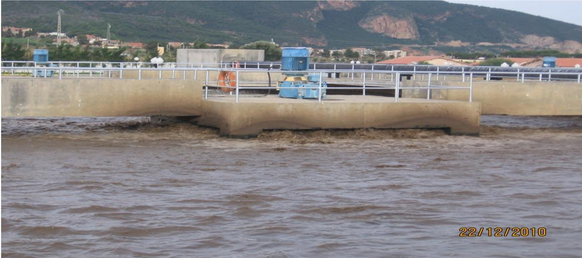
**Figure V.4: bassin d'aération biologique de la station de Tipaza [2]**
