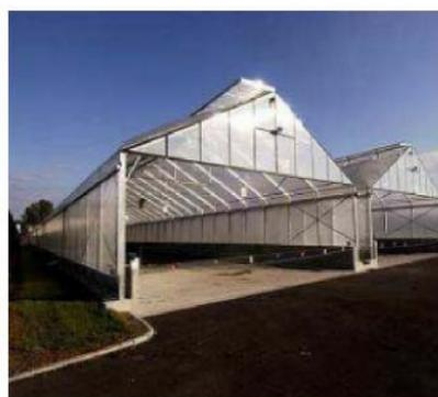
Figure II.2. Exemple de serre ouverte[3]
