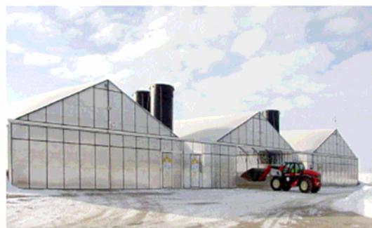
Figure II.4 Exemple de serre fermée - Extraction par cheminée [3]
