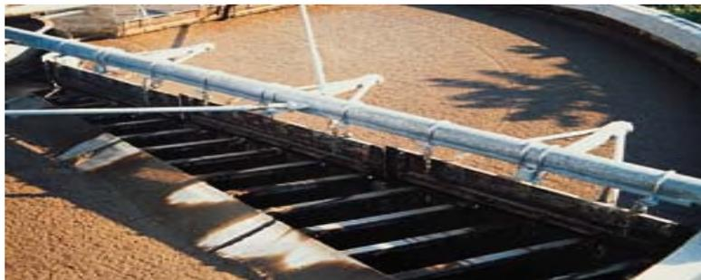
**Figure I-7: épaisseur par flottation [13]**
