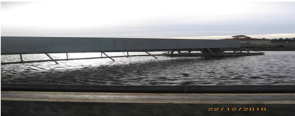
**Figure V.5: décanteur secondaire (clarificateur) en aval du traitement biologique [2]**
