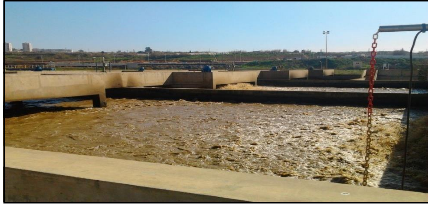
Figure 7: Bassin d'aération de la station d'épuration d'Ain Benian.
