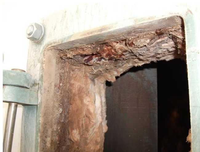
Figure 33: Le calorifuge vu à partir de la lucarne
