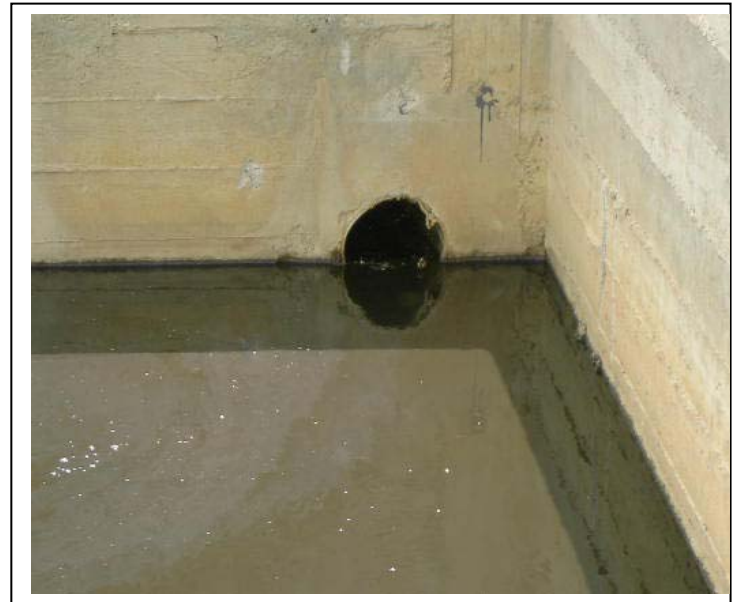
Canal d'évacuation de lixiviats
