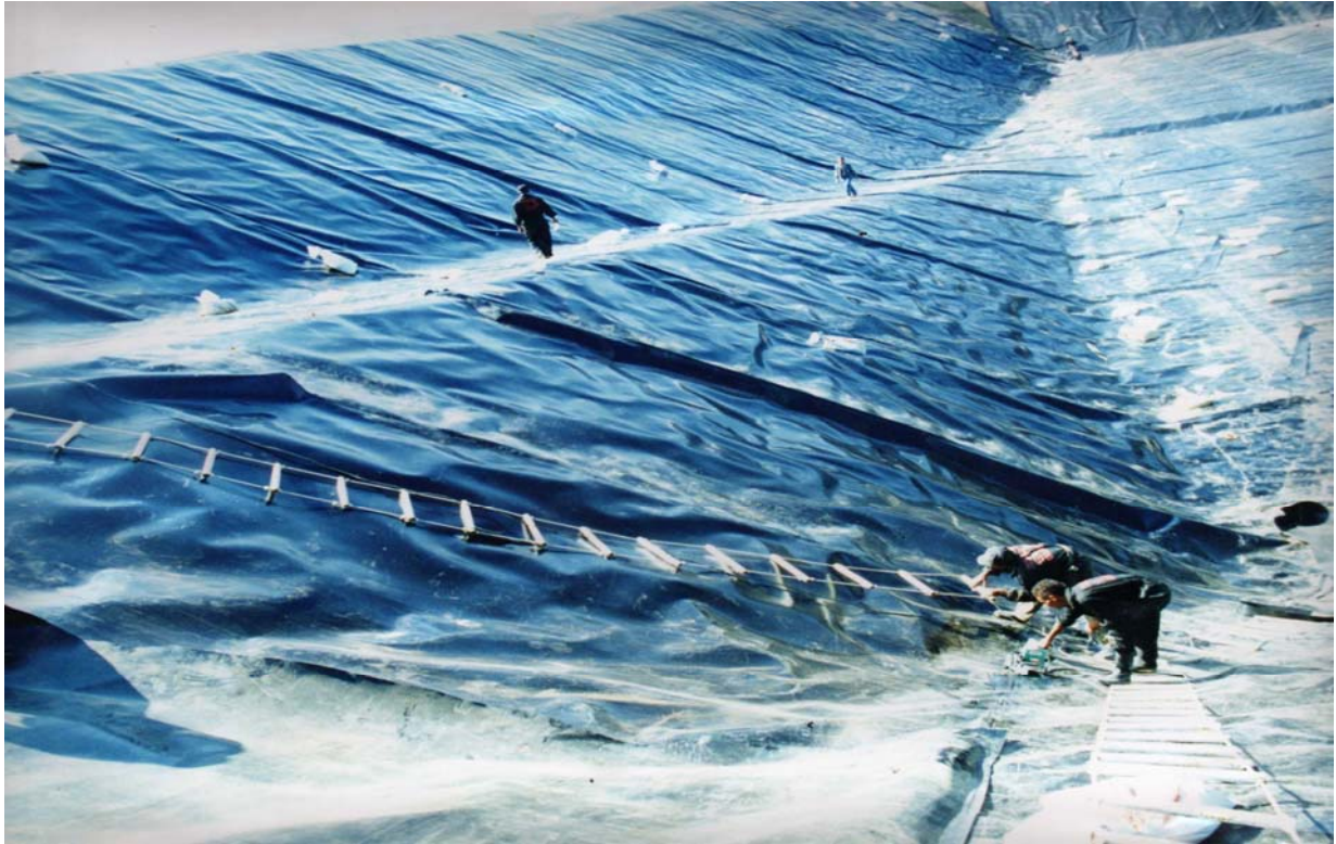
Figure V-6 : mise et soudure de la géomembrane.
