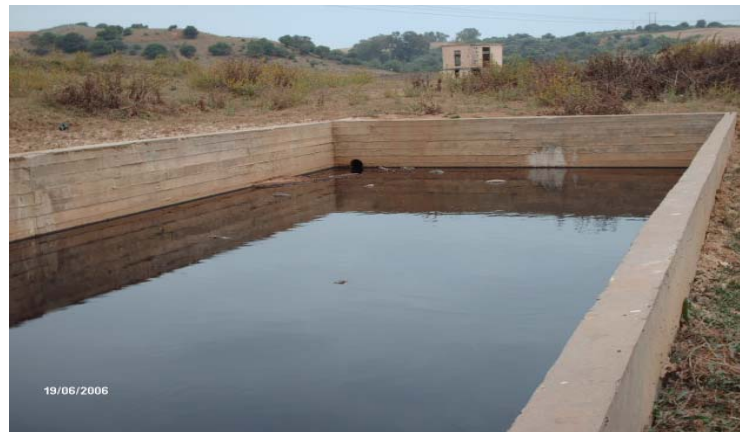
Figure 6 : le bassin de décantation de lixiviats.
