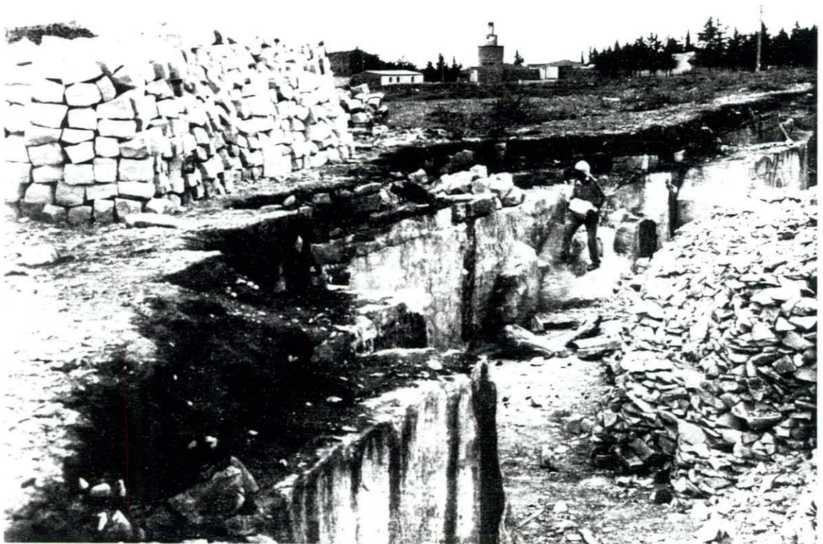
Fig. 8 L'extraction manuelle de la pierre au gisement Dhaya
