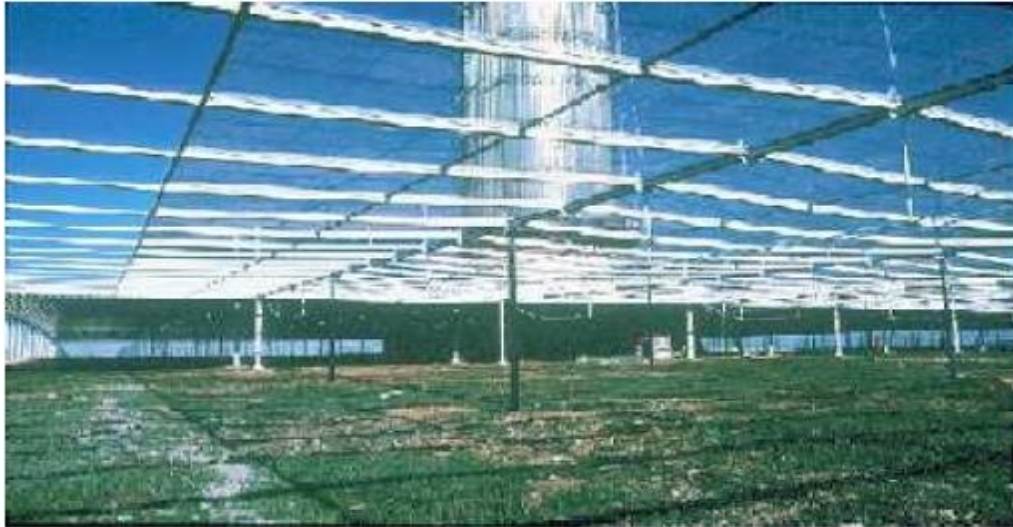
Figure I- 1 Verrière du collecteur d'une cheminée solaire.
