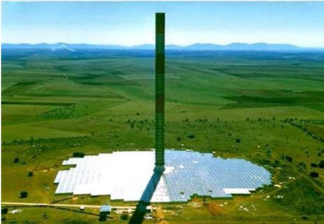
Figure I- 9 Photo de la cheminée solaire de Manzanars.
