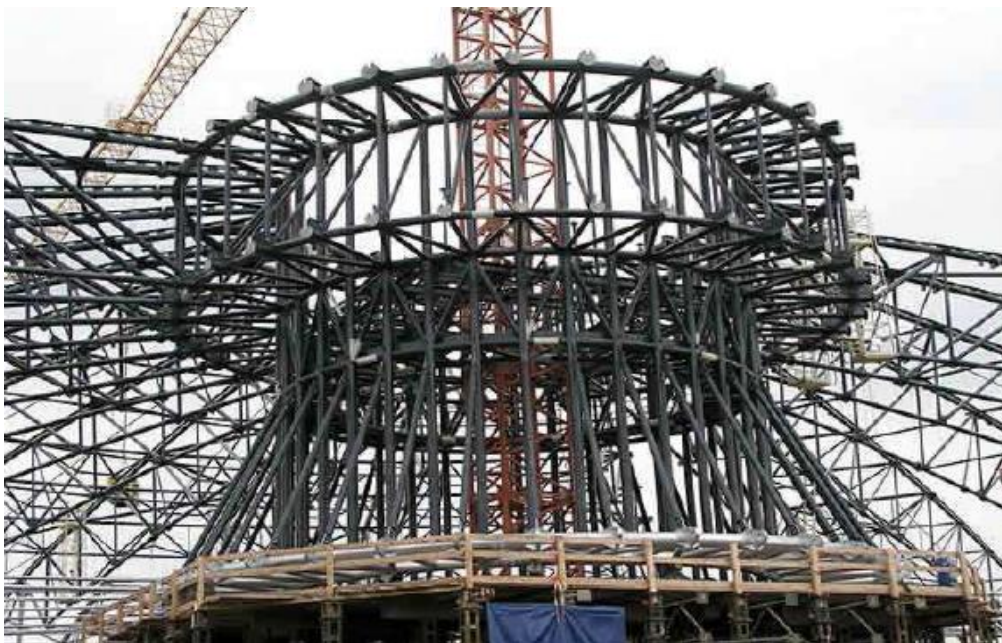
Figure I- 10 Structure de la cheminée solaire de Manzanars.
