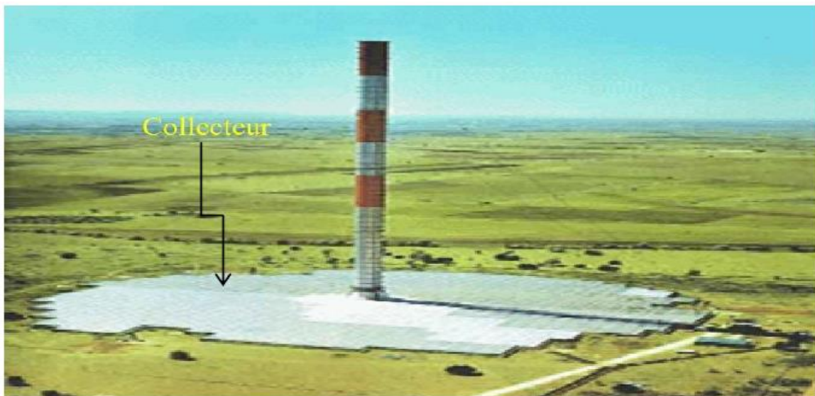
Figure I- 2 Collecteur d'une cheminée solaire.
