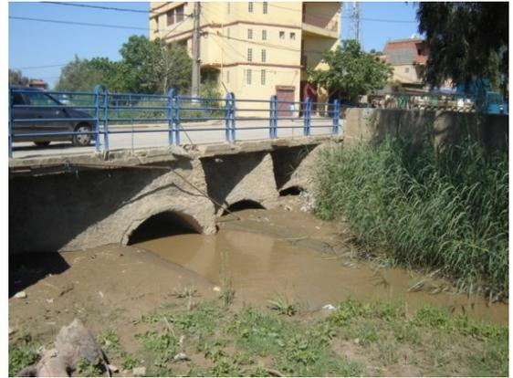
Pont sur le CW 112 menant à Boufarik – O.Thlétha- passages des eaux sous le pont obstrués par les sédiments en plein centre de Benchaabane.
