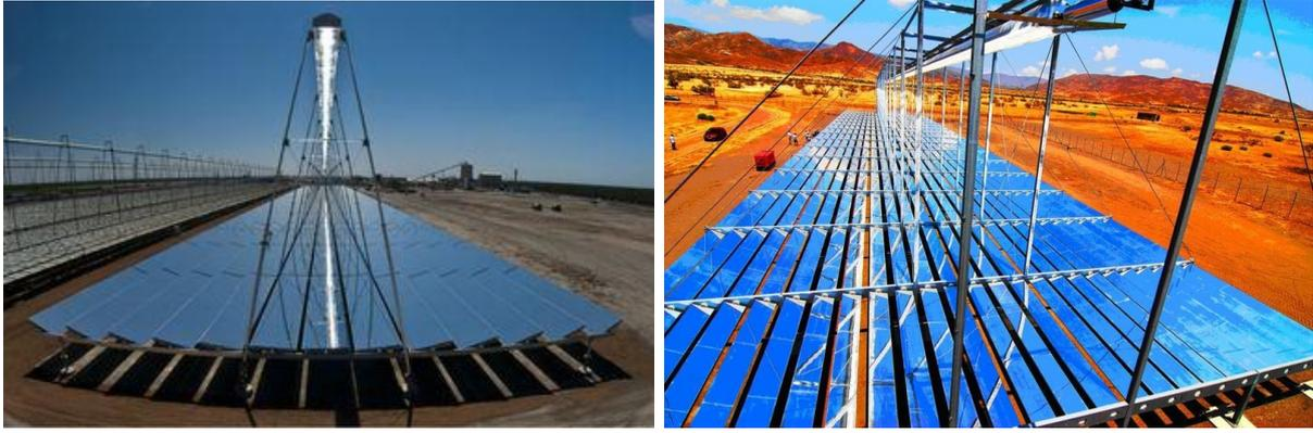
Figure 1.3 captures solaires type Fresnel
