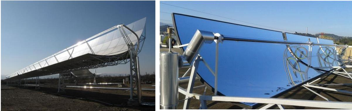
Figure 1.2 Captures cylindro-paraboliques
