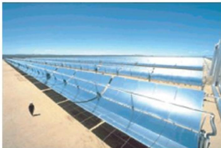
Figure 1.3 Centrales SEGS, USA, 354 MWe en 9 tranches, capteurs cylindro-paraboliques à huile, cycle de Rankine de 14 à 80 MWe
