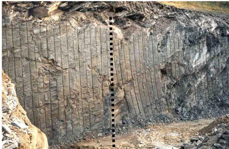
FIGURE II.1 – Déviation naturelle des forages causée par les strates du terrain (à gauche : avec tige guide pour limiter les déviations ; à droite : sans tige guide). D'après Meyer, 2002
