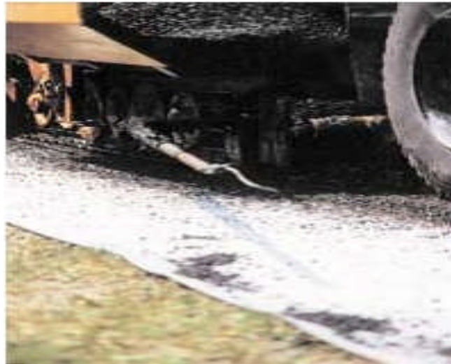
Figure.3.10. Mise en œuvre de l'enrobé sur le géotextile
