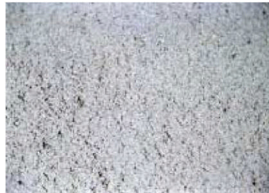
Figure.3.8. Aspect de surface avant mise en œuvre de la couche de roulement
