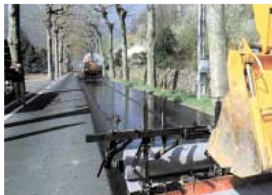
Figure.3.9. Mise en place du géotextile sur la couche d'accrochage
