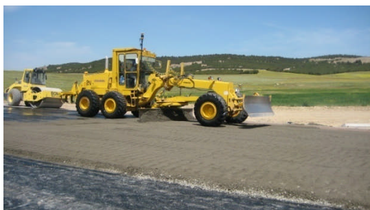
Finition par Niveleuse
