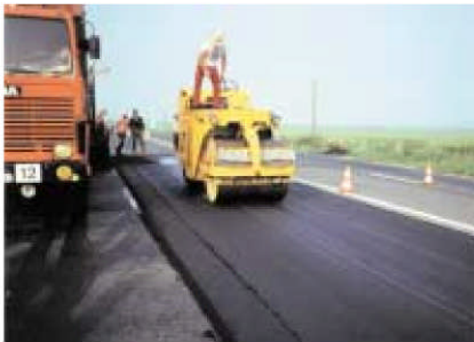
Figure.3.7. Compactage du sable enrobé antifissure
