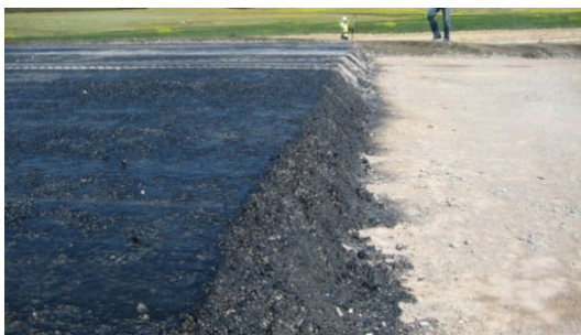
Imprégnation par Emulsion
