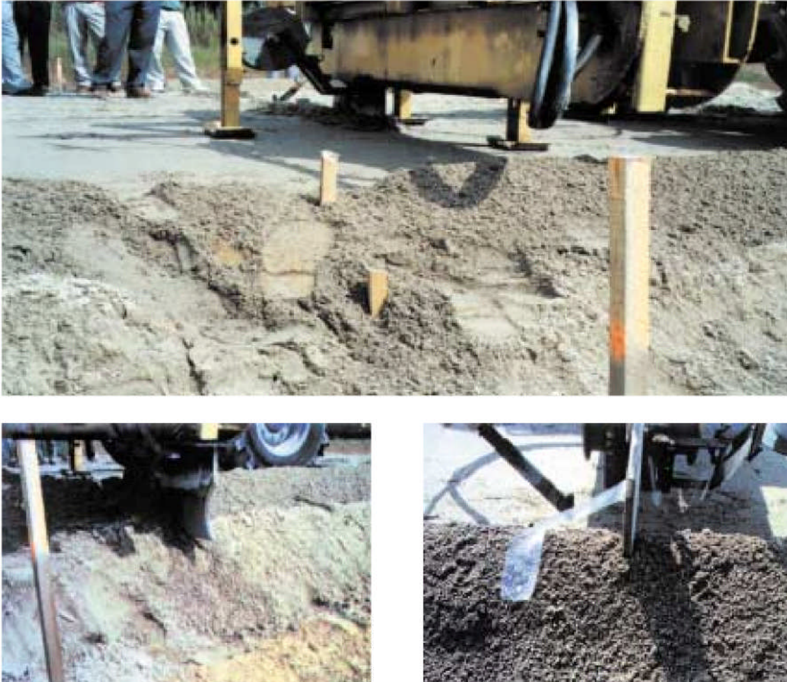
Figure.3.6. Préfissuration OLIVIA
