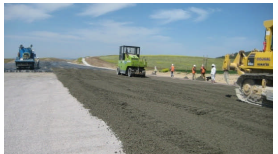
Compactage préliminaire par compacteur pneumatique
