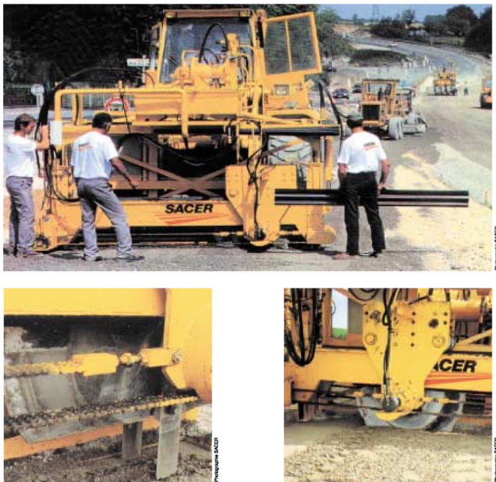
Figure.3.5. Préfissuration Joints actifs
