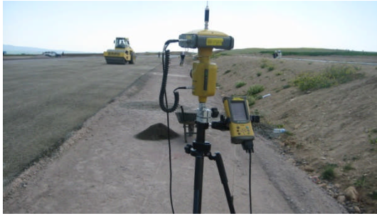
Vérification de l'épaisseur par GPS
