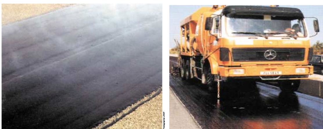
Figure.3.11. Mise en œuvre d'un enrobé coulé à froid pour protéger la membrane.
