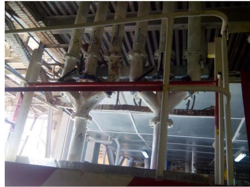
Figure II-5- Vannes de transport pneumatique
